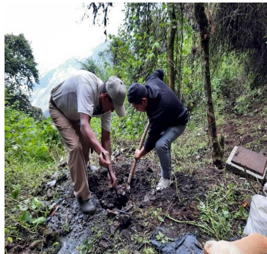
Figura 24. Excavación para calicata en captación “Cerro Chacas”
