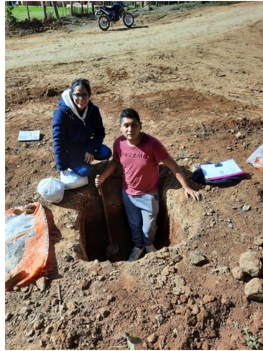
Figura 29. Excavación para calicata de la línea de distribución
