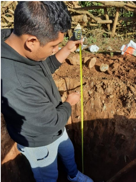
Figura 29. Excavación para calicata de la línea de distribución
