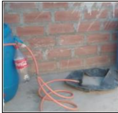
Figura 20. Almacenamiento del biogás
