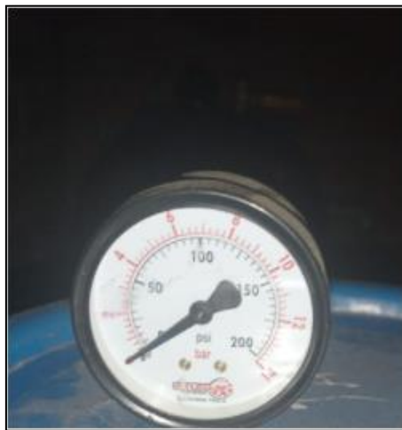
Figura 19. Medición de la presión del biogás
