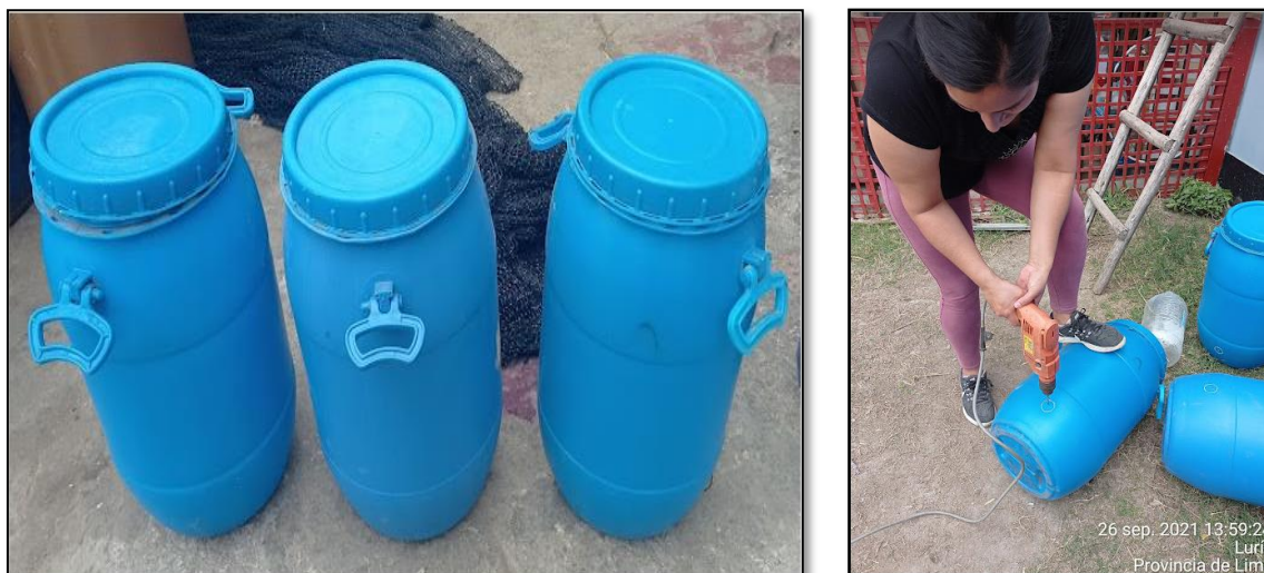
Figura 4. Perforaciones de los bidones para armar el biodigestor
