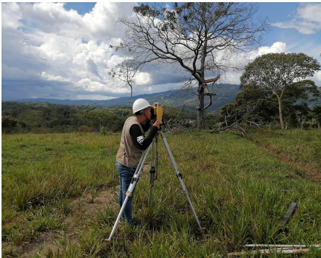
Foto N.º 06 Levantamiento Topográfico de la línea de conducción
