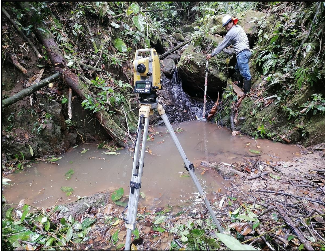
Foto N.º 07 Levantamiento Topográfico de la Captación
