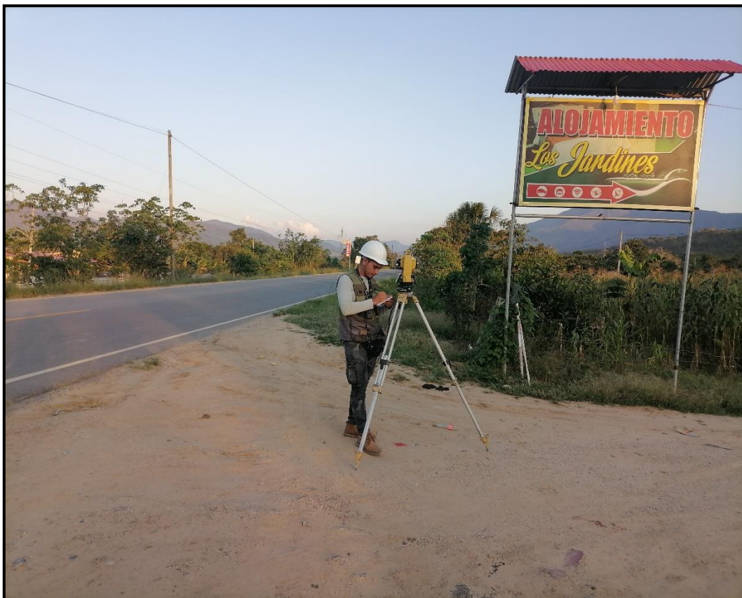
Foto N.º 04 Levantamiento topográfico de la red de distribución y línea de aducción
