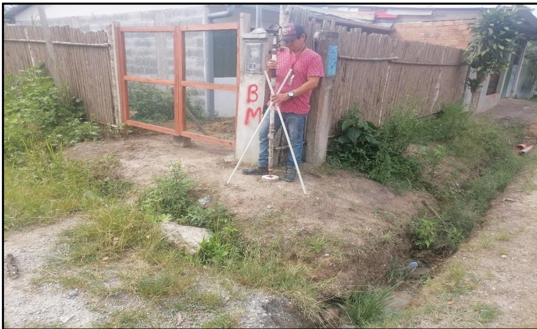
Foto N.º 02 Personal de apoyo realizando la referenciación de los BM,s y puntos de control
