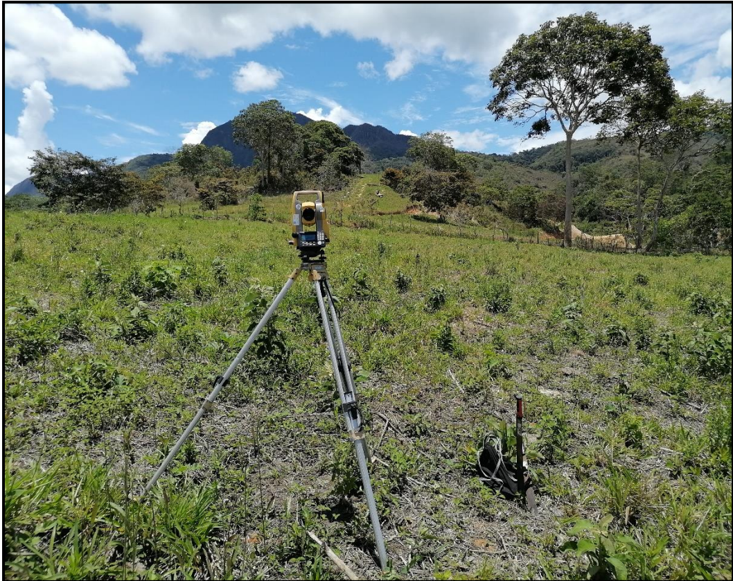
Foto N.º 05 Levantamiento topográfico de la Planta de Tratamiento de Agua Potable.
