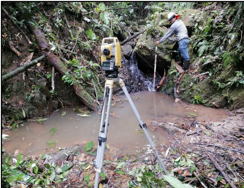
Imagen 3: Finalización del Levantamiento Topográfico.
