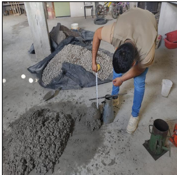
Figura 21. Ensayo de asentamiento “Slump 4” Cono de Abrams.
