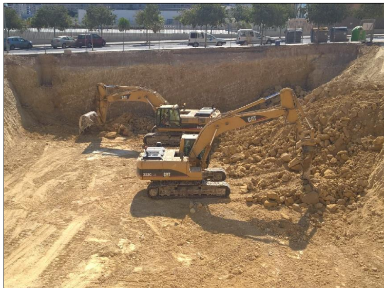
Figura N° 6. Excavación para sótano.
