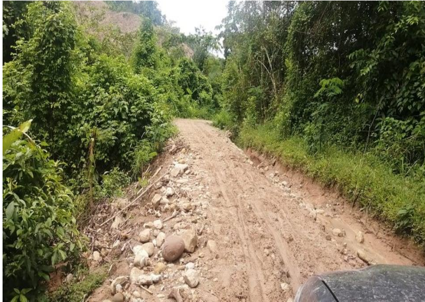
Vista fotográfica: Imagen donde se muestra contaminación de plataforma con liga, por colmatación de cunetas.
