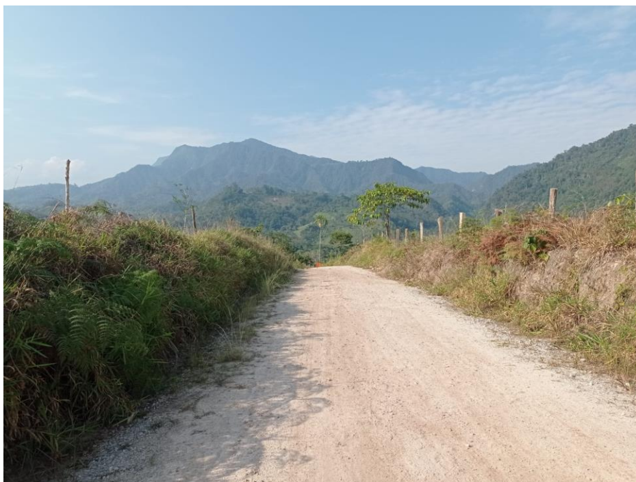
Vista fotográfica: Situación actual vía en mal estado.
