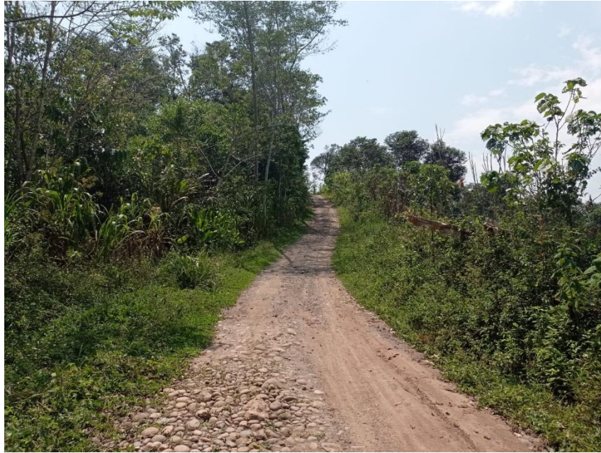
Vista fotográfica: Situación actual de la vía en estudio en mal estado en el C.P Belén hacia La Encañada y con terreno de cultivo.
