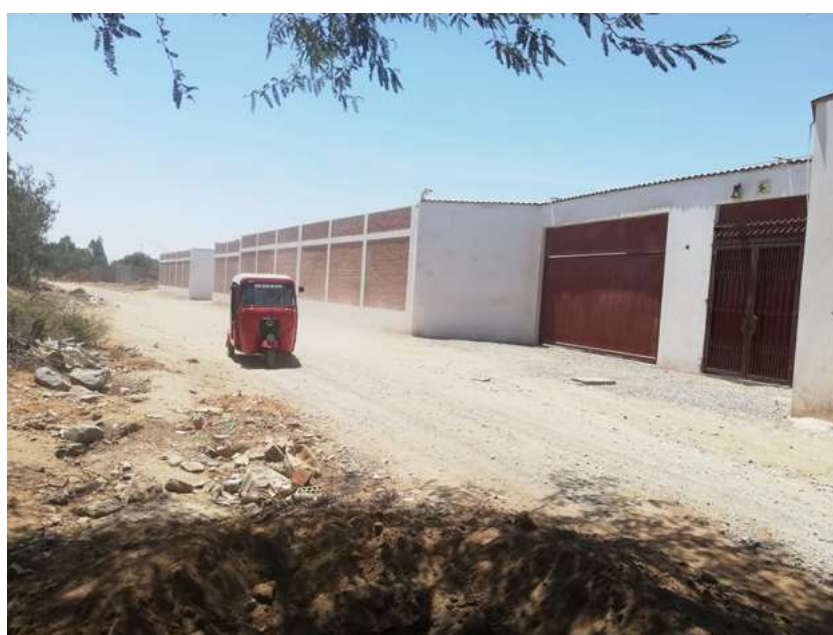
Reconocimiento de campo -Tramo de la vía IC 688
