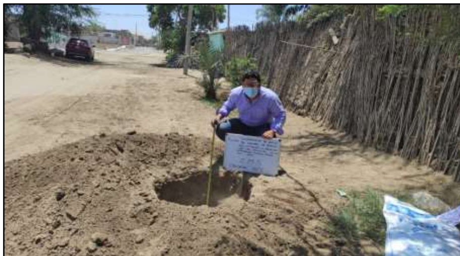
Figura 14. Extracción de material Calicata N° 1
