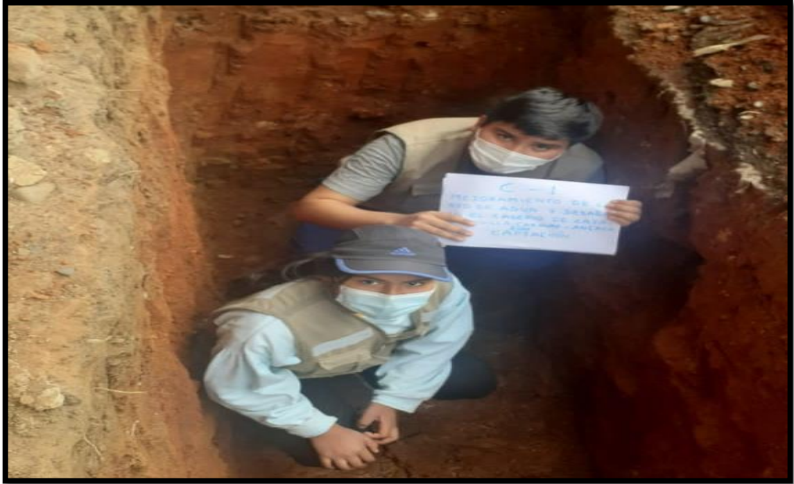
Foto N° 11: Realización de Calicatas.
