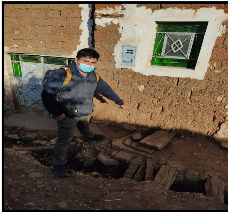
Foto N° 10: Verificación de cajas de registros
