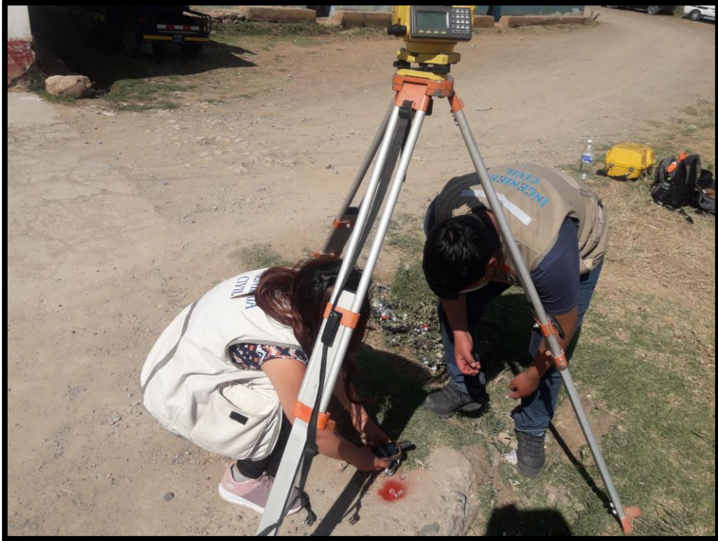
Foto N° 07: Levantamiento topográfico en el Caserío de Cajamarquilla
