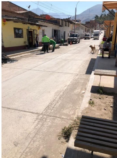
Foto 28. Trabajadores municipales realizando labores de limpieza de alcantarillado
