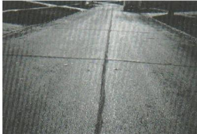
Figura A8-a. Grieta de reflexión de junta de baja severidad.
