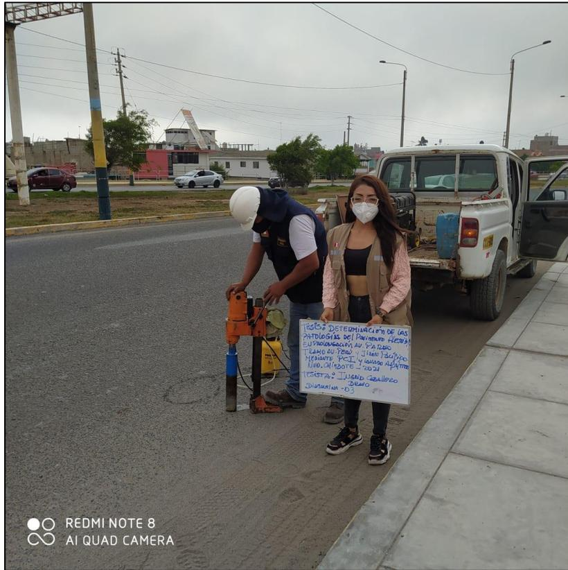
Foto N°9: Aplicación del ensayo diamantina N°3 en la progresiva 00+030.00-Tramo N°2
