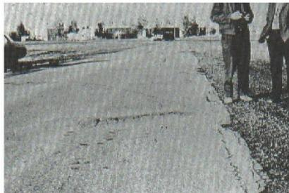
Figura A4-b. Abultamientos y hundimientos de severidad media.
