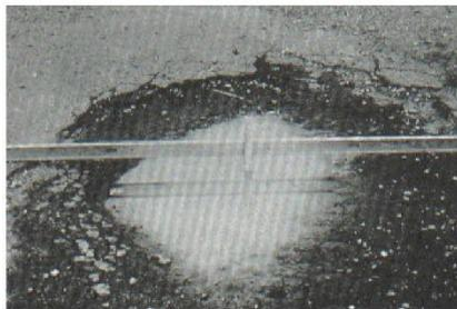
Figura A13-c. Hueco de severidad alta.
