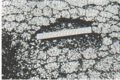
Figura A13-a. Hueco de baja severidad.
