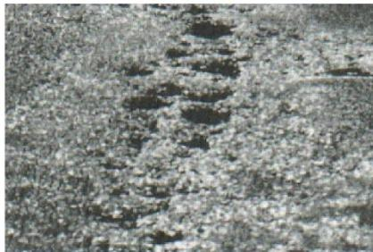
Figura A19-c. Meteorización / desprendimiento de agregados de alta severidad.
