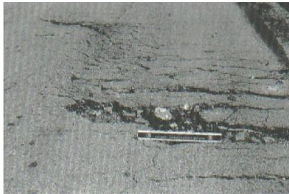
Figura A17-c. Grieta parabólica (slippage) de alta severidad.
