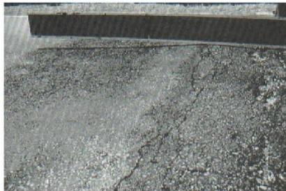
Figura A4-c. Abultamientos y hundimientos de alta severidad.
