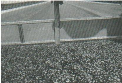
Figura A15-b. Ahuellamiento de severidad media.
