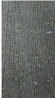
Figura A2-c. Exudación de alta severidad.
