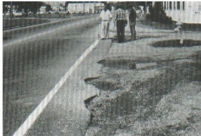
Figura A7-c. Grieta de borde de alta severidad.
