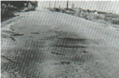
Figura A16-b. Desplazamiento de severidad media.
