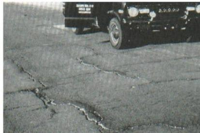
Figura A3-c. Grietas en bloque de alta severidad.
