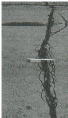
Figura A8-c. Grieta de reflexión de junta de alta severidad.
