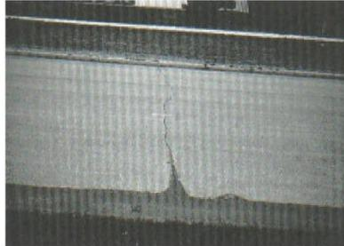
Figura A10-a. Grietas longitudinales y transversales (No PCC) de baja severidad.
