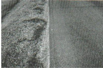
Figura A7-a. Grieta de borde de baja severidad.
