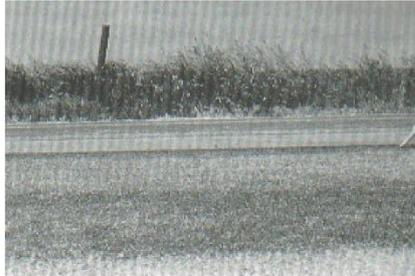
Figura A5-a. Corrugación de baja severidad.
