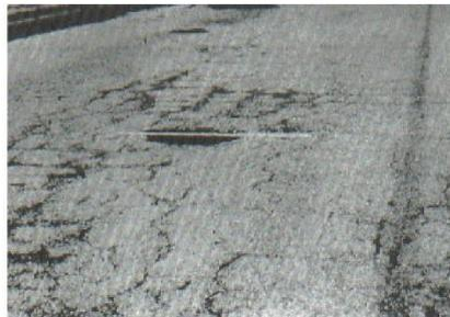
Figura A13-b. Hueco de severidad media.
