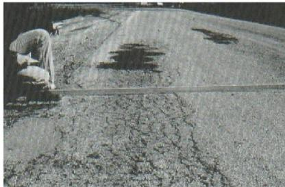
Figura A1-c. Piel de cocodrilo de alta severidad.
