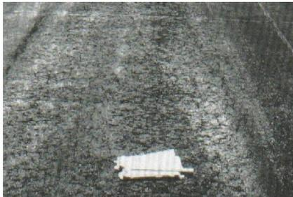
Figura A19-b. Meteorización / desprendimiento de agregados de severidad media.
