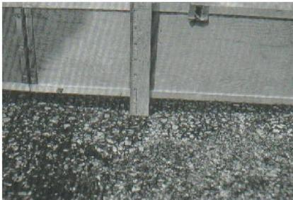
Figura A15-c. Ahuellamiento de alta severidad.
