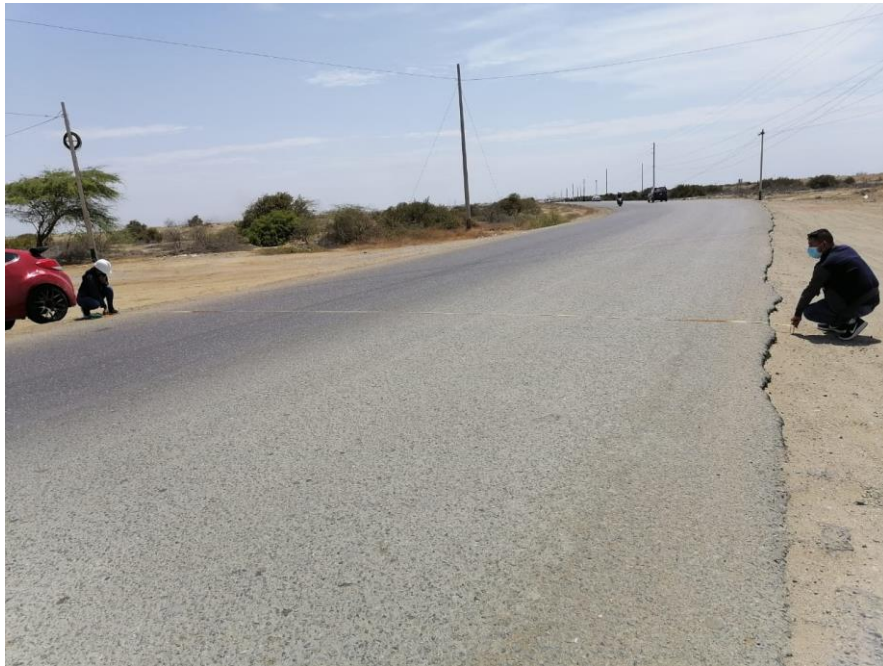
Fotografía 1. Evaluación del pavimento de la via de acceso a Talara.
