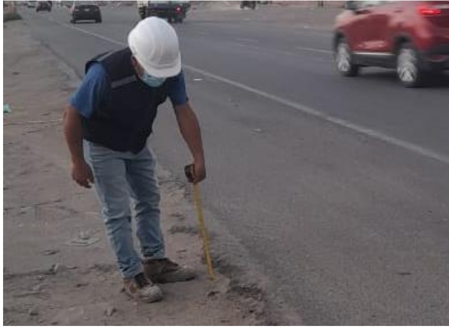
Fotografía 5. Evaluación del pavimento de la vía de acceso a Talara.
