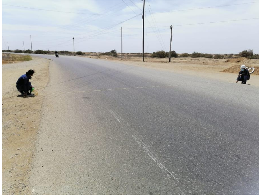
Fotografía 3. Evaluación del pavimento de la via de acceso a Talara.
