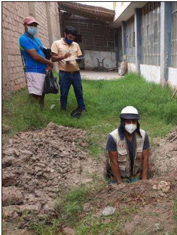
Figura 33. Vista de la Calicata C-03, 14-06-2021.
