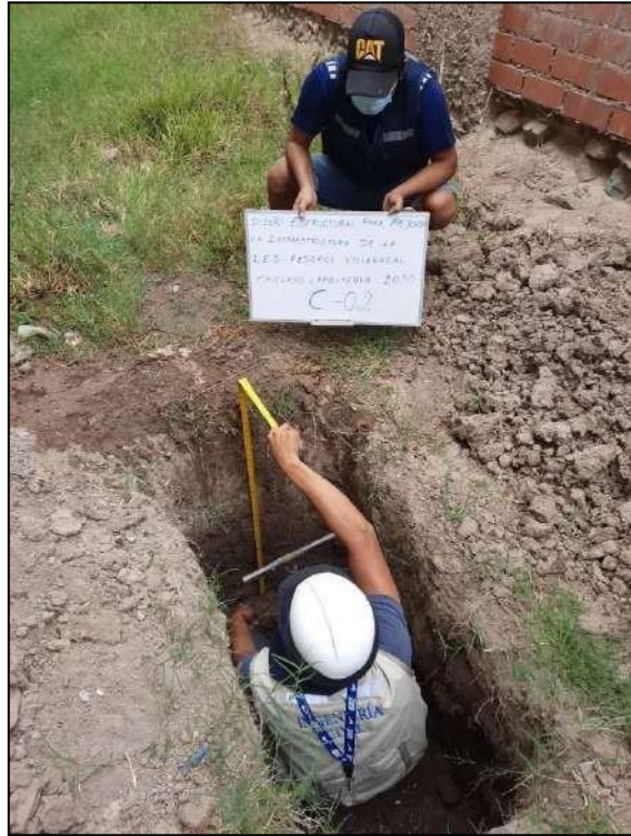
Figura 32. Vista de la Calicata C-02, 13-06-2021.
