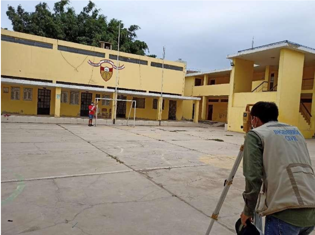
Figura 6. Visación, desde el área de Plataforma, en dirección al Pabellón B, 8-06-2021.
