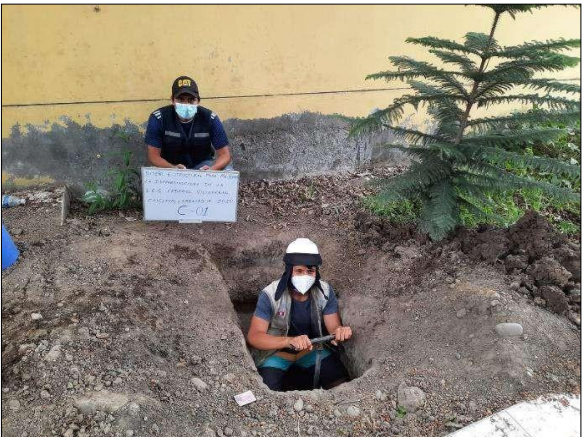
Figura 31. Vista de la Calicata C-01, 13-06-2021.
