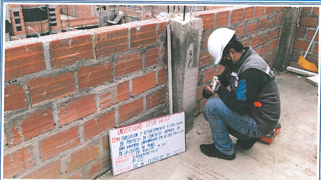
VISTA 07: REGISTRO DE DATOS DEL ENSAYO DE ESCLEROMETRIA PUNTO-02, PROYECTO UNIFAMILIAR URB. VALLECITO – PUNO.
