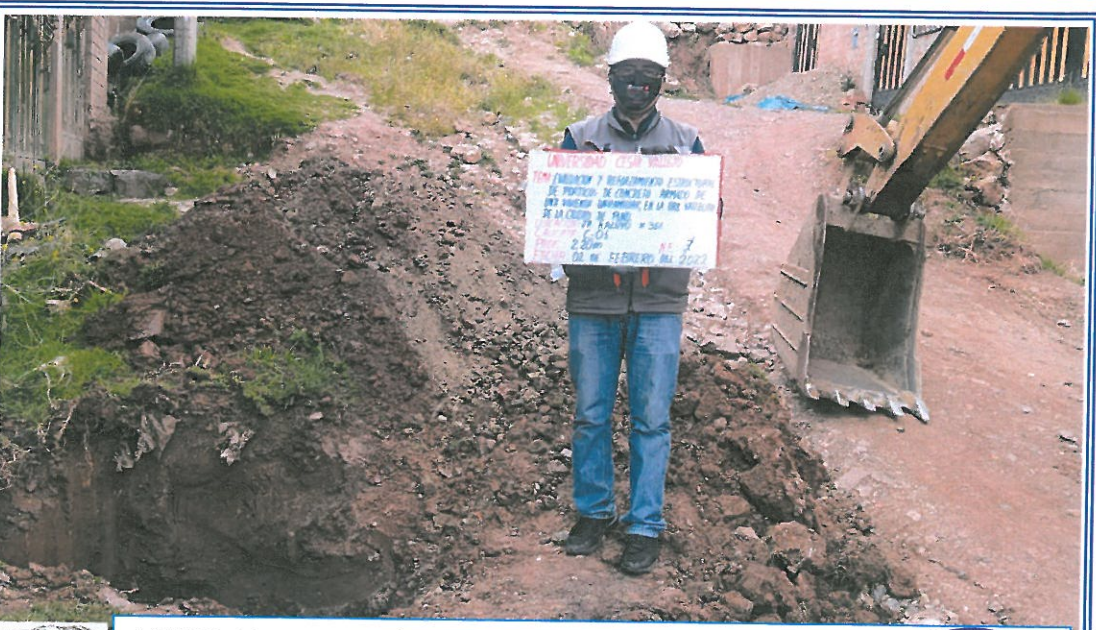
VISTA 02: UBICACIÓN DE LA CALICATA-01, PROYECTO UNIFAMILIAR URB. VALLECITO - PUNO.
