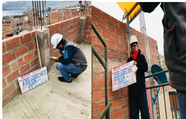
Figura 3. Realización de ensayo de Esclerometría
