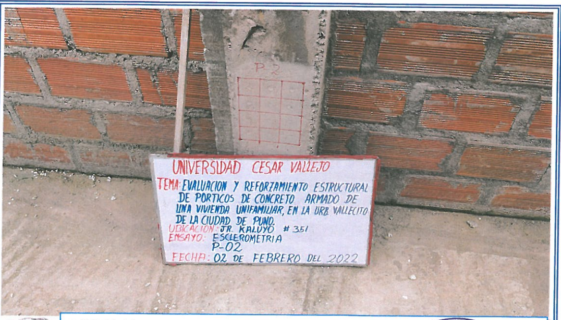
VISTA 08: CONCLUYENDO EL ENSAYO DE ESCLEROMETRIA PUNTO-02, PROYECTO UNIFAMILIAR URB. VALLECITO – PUNO.
