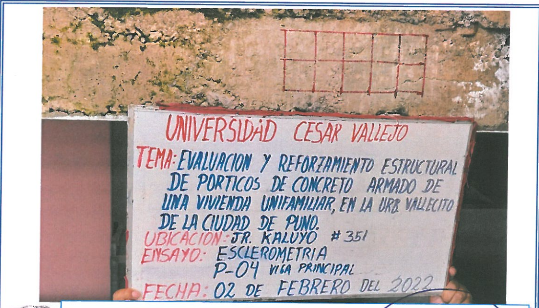
VISTA 14: CONCLUYENDO EL ENSAYO DE ESCLEROMETRIA PUNTO-04, PROYECTO UNIFAMILIAR URB. VALLECITO – PUNO.
