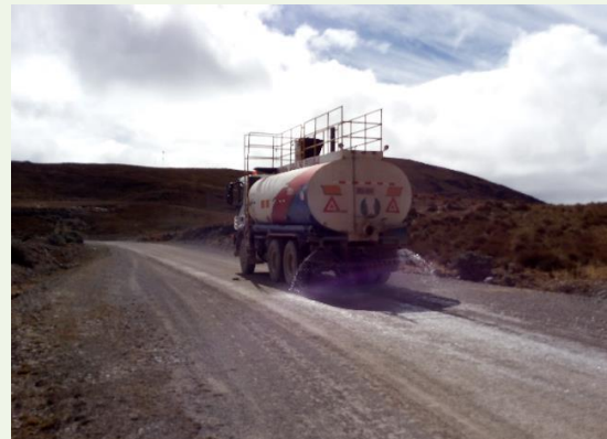
Riego de vías en acceso Pongo- Conga. Tramo Mar II.
