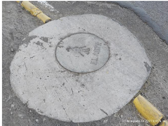
Figura 48 Red Conexión energía eléctrica y telecomunicaciones en el terreno
