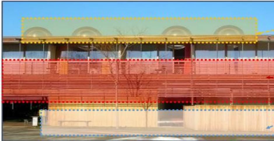
Se buscó el contacto con el exterior a través de teatinas y galerías que ayuden a ventilar e iluminar el interior.
