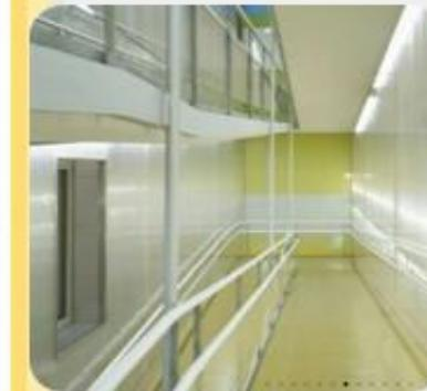
Como elemento singular de la estructura tenemos un sistema de rampas que comunica verticalmente todo el edificio, construidas con losas de hormigón armado de 15cm de espesor y perfiles en U colocados longitudinales a los bordes.
