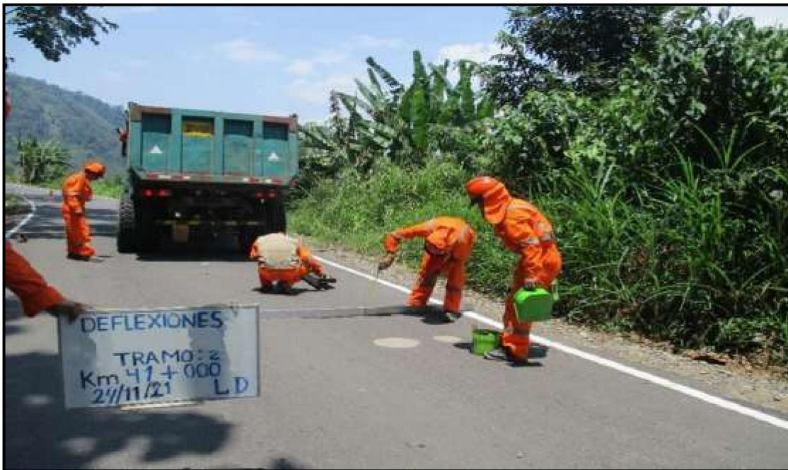
Foto 3. Medición de deflexiones en el tramo Sivia - Canayre. (lado derecho)
