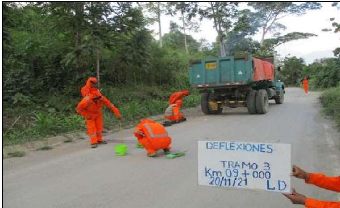
Foto1. Medición de deflexiones en el tramo San Fransisco – Palmapampa (lado derecho)
