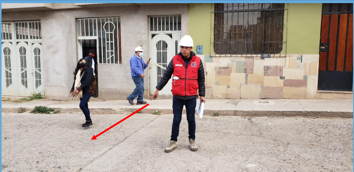
Fotografía 08. Reconocimiento de fallas tipo agregado pulido de severidad alta. Puno 2021.
