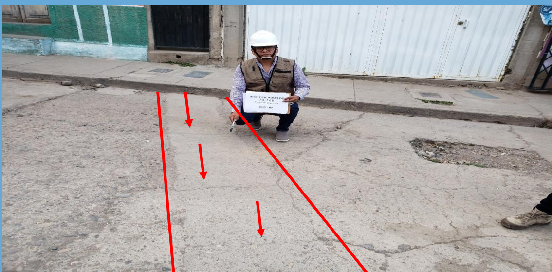
Fotografía 30. Reconocimiento de fallas tipo parches grandes de severidad alta. Puno 2021.
