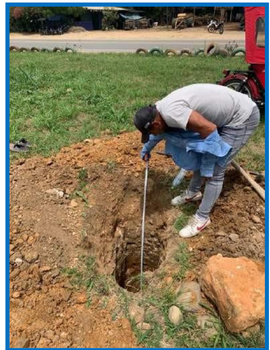
Figura 49: Imagen del levantamiento topográfico en el jirón vía de evitamiento cuadra 26.
