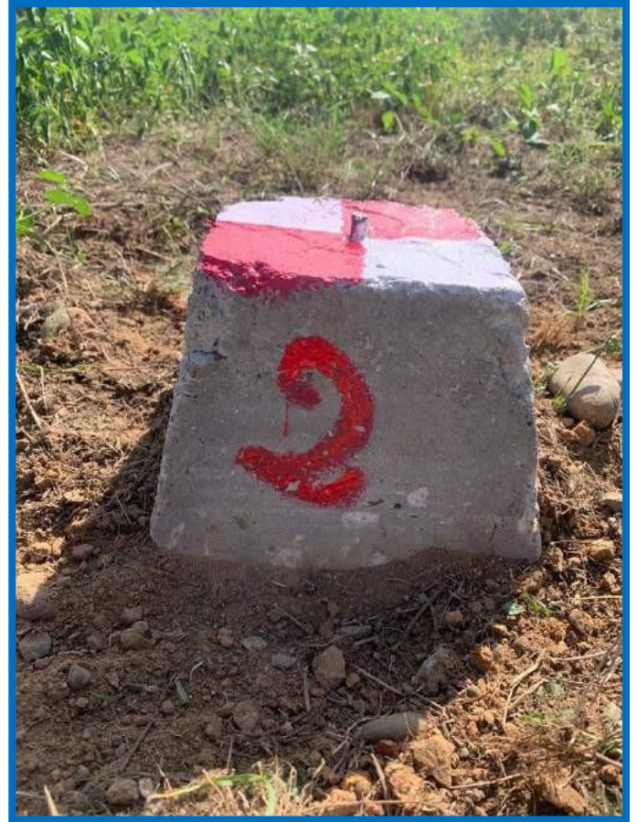
Figura 21: Imagen de la colocación y pitado del BM.
