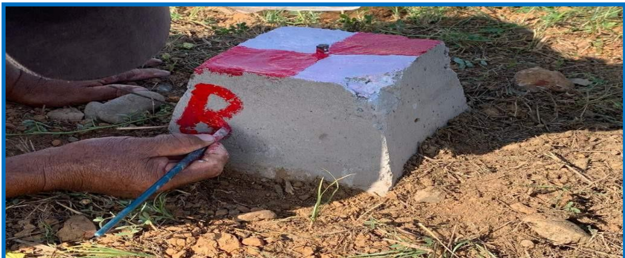
Figura 22: Imagen de la colocación y pitado del BM.
