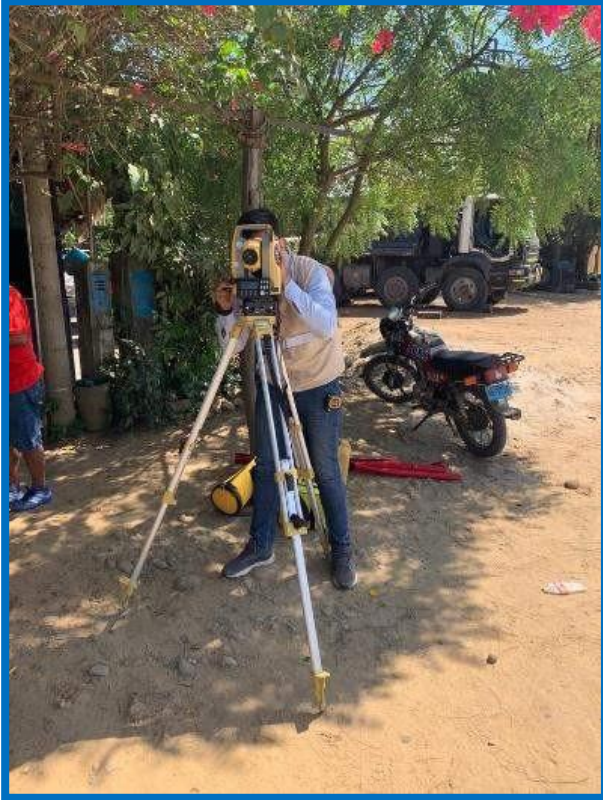
Figura 14: Imagen del levantamiento topográfico en el jirón vía de evitamiento cuadra 26.
