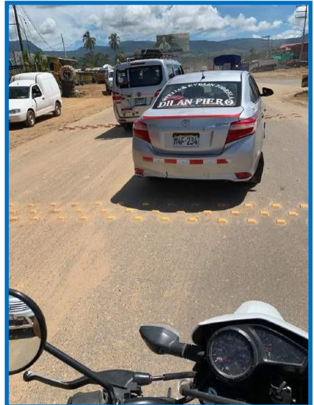
Figura 40: Se observa en la imagen colocación de ojos de gato en la zona.
