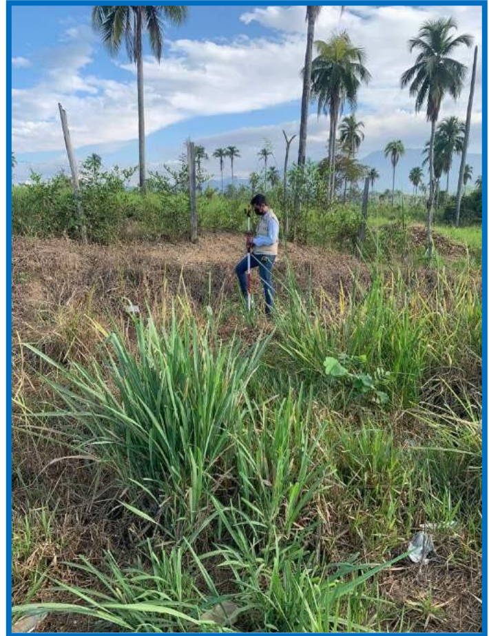
Figura 24: Imagen del levantamiento topográfico en el jirón vía de evitamiento cuadra 26.
