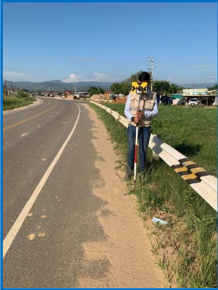
Figura 26: Imagen del levantamiento topográfico en el jirón vía de evitamiento cuadra 26.
