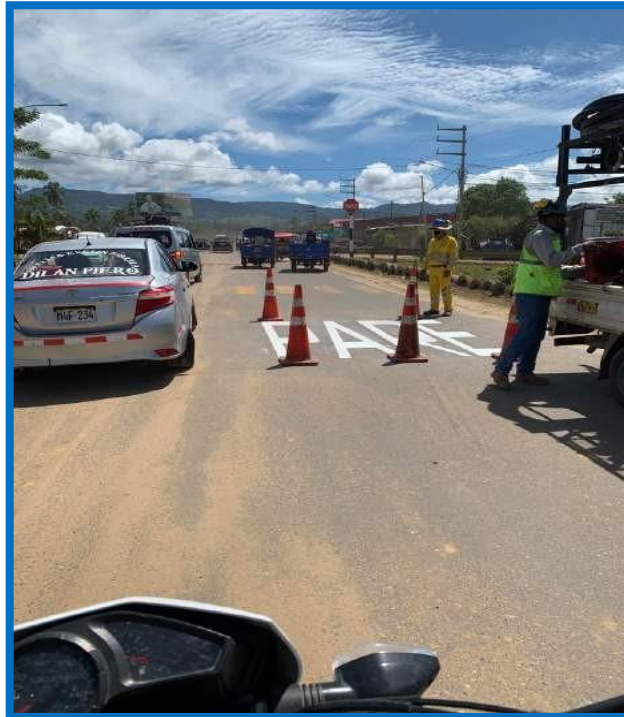
Figura 41: Se observa en la imagen la implementación de señales horizontales.
