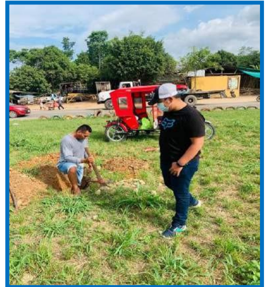
Figura 47: Imagen del levantamiento topográfico en el jirón vía de evitamiento cuadra 26.
