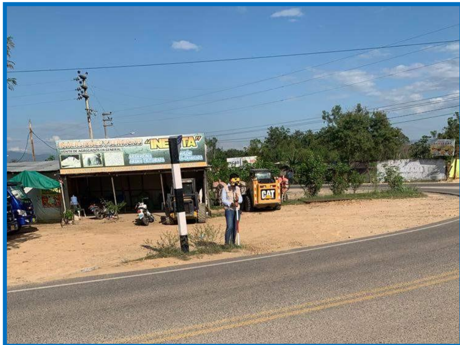
Figura 28: Imagen del levantamiento topográfico en el jirón vía de evitamiento cuadra 26.
