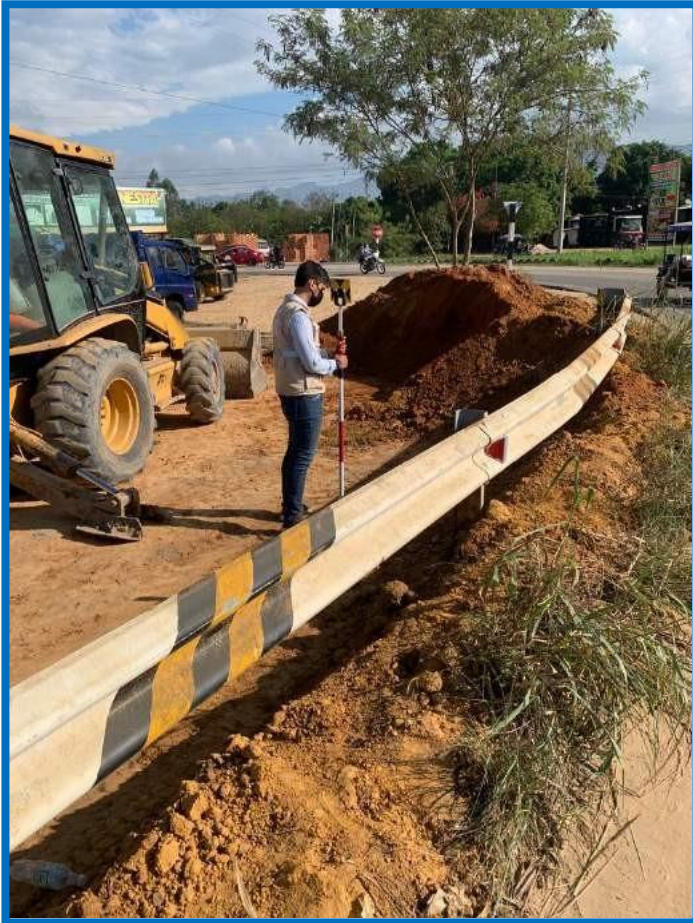
Figura 23: Imagen del levantamiento topográfico en el jirón vía de evitamiento cuadra 26.
