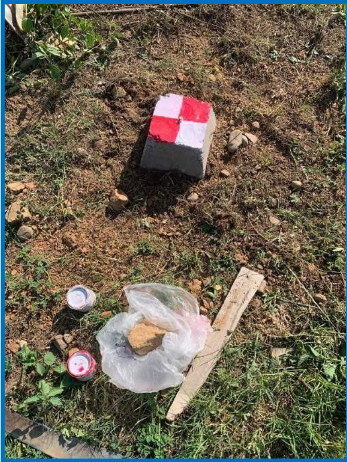
Figura 20: Imagen de la colocación y pitado del BM.
