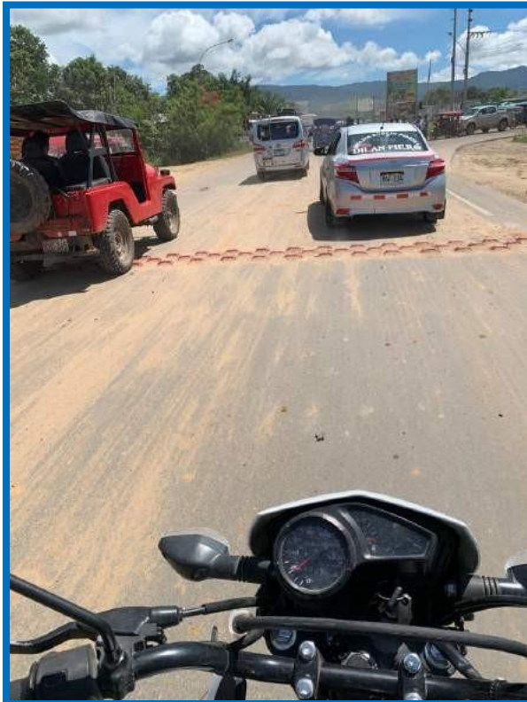
Figura 39: Se observa en la imagen colocación de ojos de gato en la zona.
