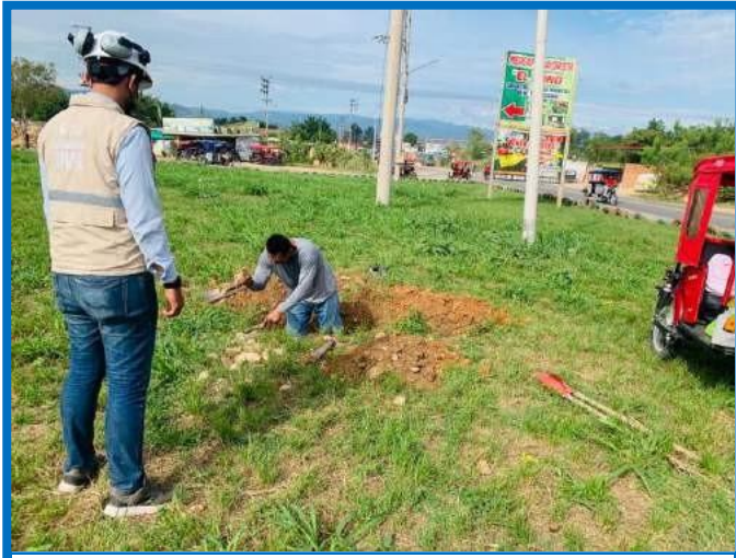
Figura 46: Imagen del levantamiento topográfico en el jirón vía de evitamiento cuadra 26.
