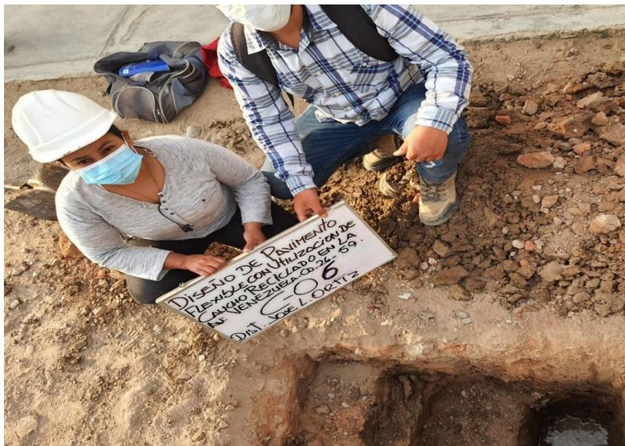
Foto N°14: Término de excavación de calicata C-06, con hallazgo de napa freática.
