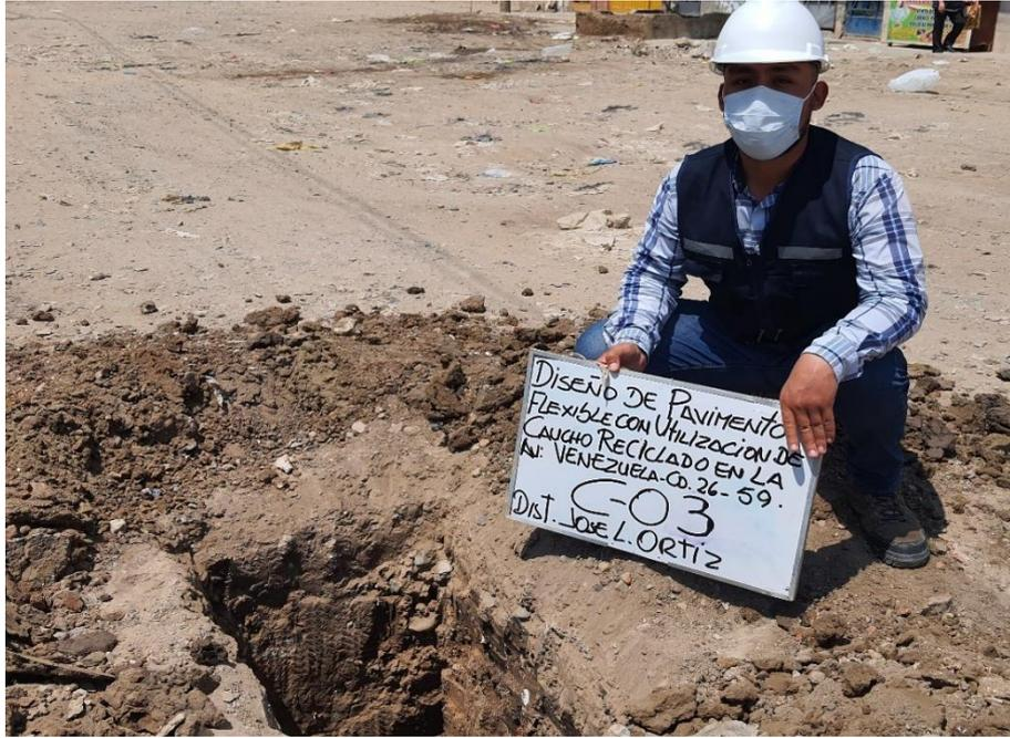
Foto N°11: Término de excavación de calicata C-03.
