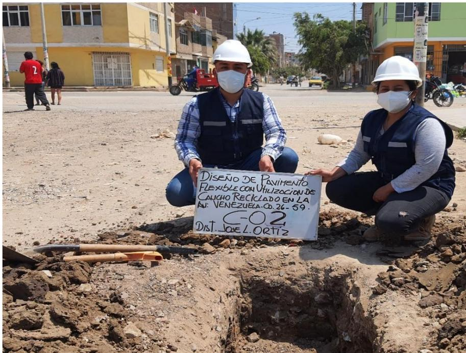
Foto N°10: Término de excavación de calicata C-02.
