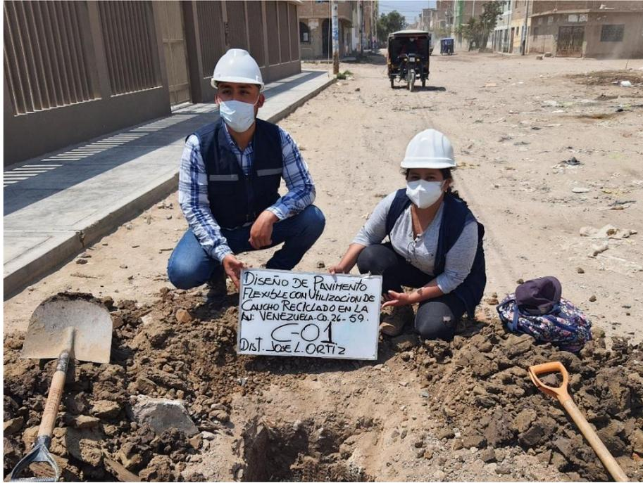
Foto N°09: Término de excavación de calicata C-01.
