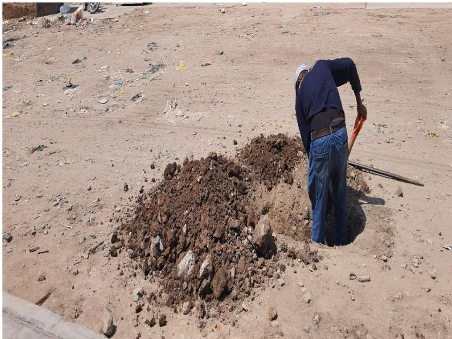
Foto N°08: Inicio de excavaciones de calicatas para la toma de muestras de suelo.
