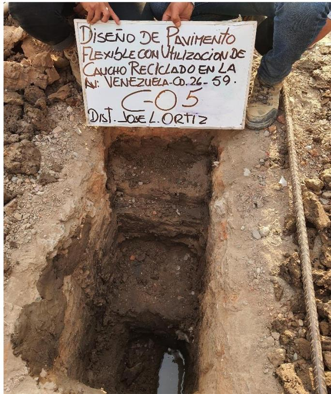
Foto N°13: Término de excavación de calicata C-05, con hallazgo de napa freática.
