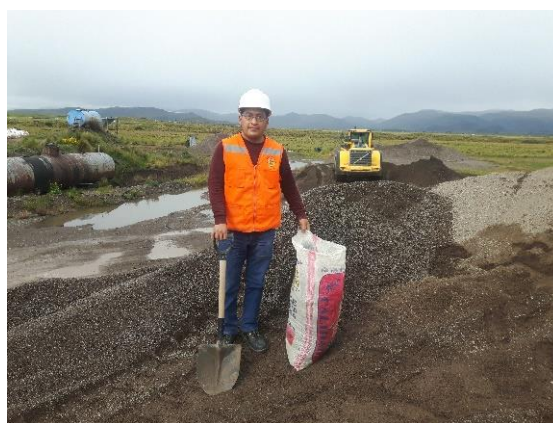
Figura 6: Extracción agregado fino Fuente: Elaboración propia.
