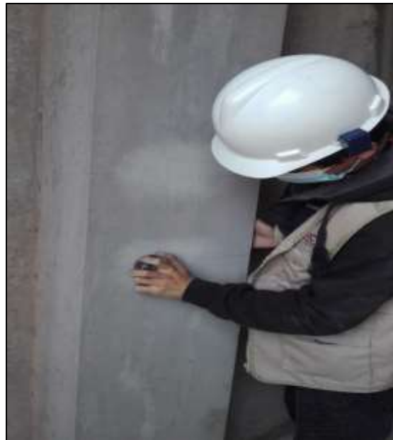
Figura 33. Limpieza de la zona de ensayo
