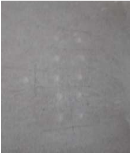
Figura 5. Zona de prueba del elemento de concreto.
