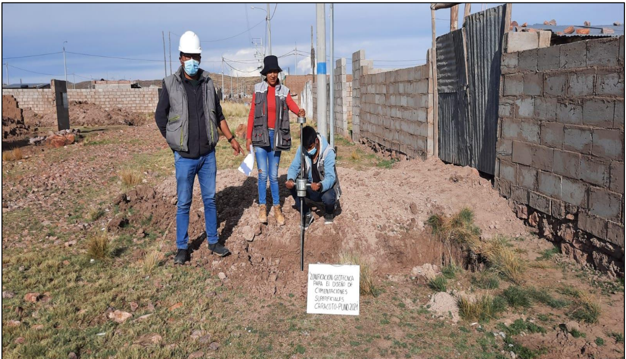
16.- Se realiza el ensayo DPL, dentro de las 18 calicatas ubicadas en el proyecto.
