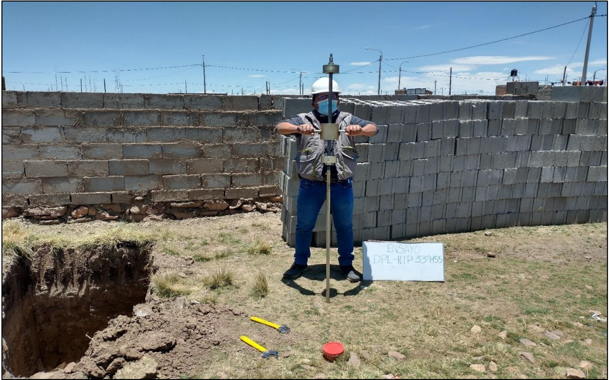
15.- Se realiza el ensayo de DPL, contando el numero de golpes a cada 10 cm, sobre el terreno natural.
