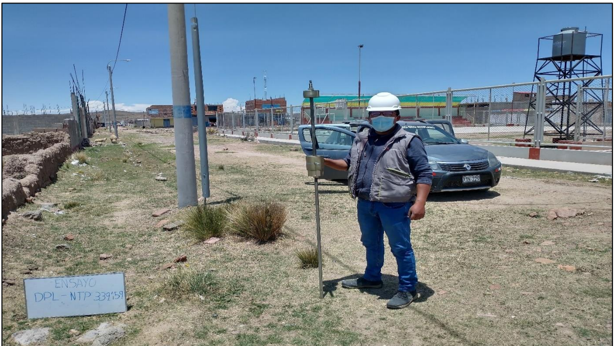
14.- Se realiza el ensayo DPL dentro del proyecto, para determinar su capacidad de carga del terreno.
