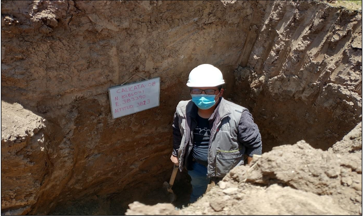
3.- Excavación de calicata a Profundidad de 3.00m para la toma de muestras dentro del proyecto.
