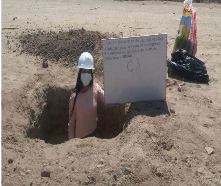
Figura 4. Pueblo Nuevo: Ubicación de calicata C-3, Km 1+000, abril 2021
