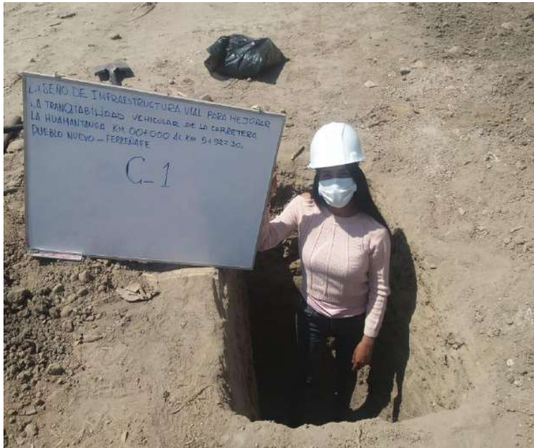
Figura 2. Pueblo Nuevo: Ubicación de calicata C-1, Km 00+000, abril 2021
