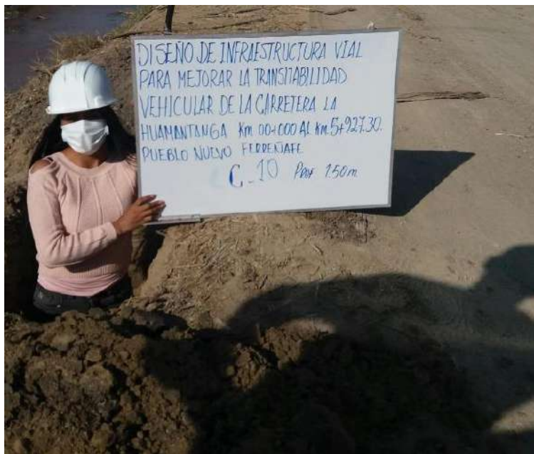
Figura 11. Pueblo Nuevo: Ubicación de calicata C-10, Km 4+500, abril 2021
