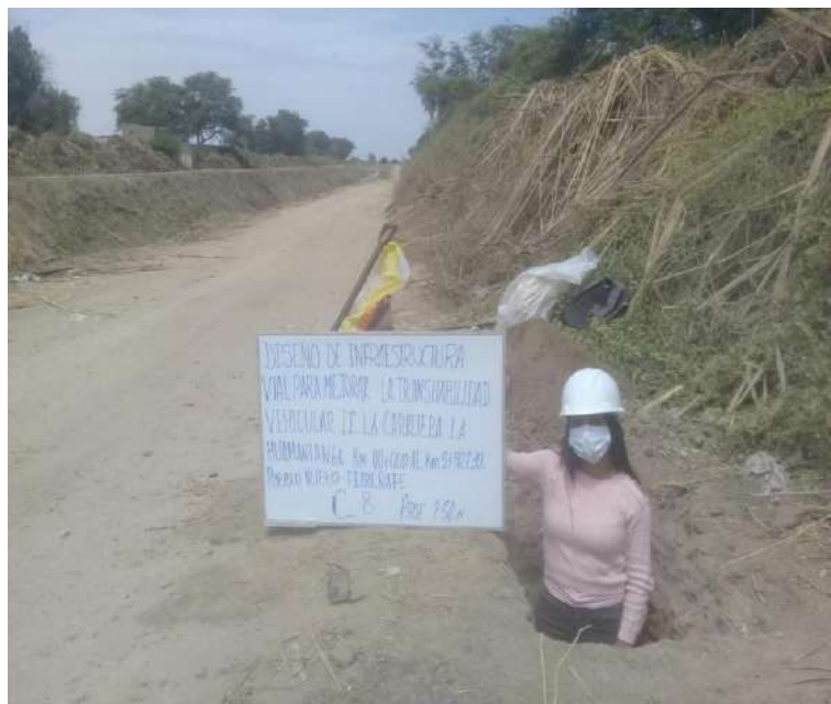
Figura 9. Pueblo Nuevo: Ubicación de calicata C-8, Km 3+500, abril 2021
