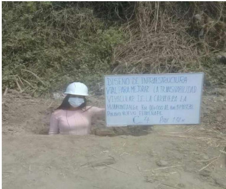
Figura 5. Pueblo Nuevo: Ubicación de calicata C-4, Km 1+500, abril 2021
