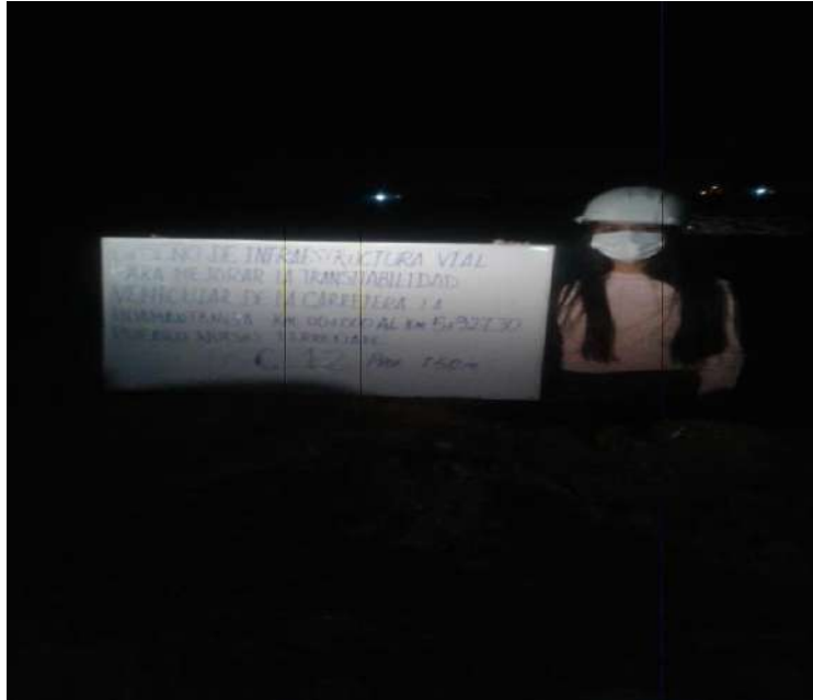
Figura 14. Pueblo Nuevo: Ubicación de calicata C-12, Km 5+974, abril 2021
