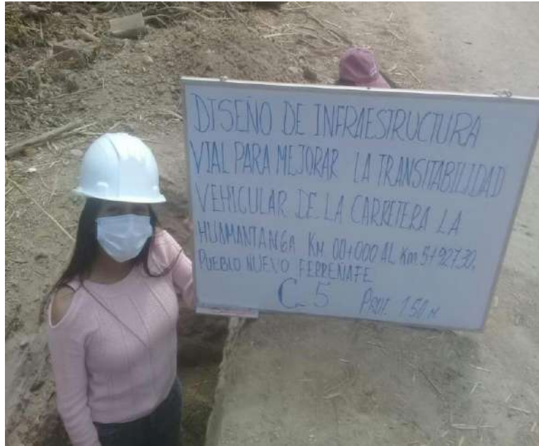
Figura 6. Pueblo Nuevo: Ubicación de calicata C-5, Km 2+000, abril 2021
