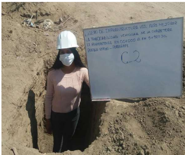
Figura 3. Pueblo Nuevo: Ubicación de calicata C-2, Km 00+500, abril 2021
