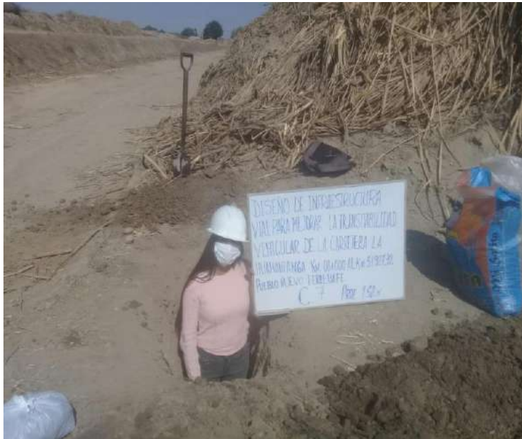
Figura 8. Pueblo Nuevo: Ubicación de calicata C-7, Km 3+000, abril 2021
