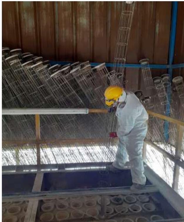
*Figura N°19. Uso correcto de los EPP'S para puesto específico de trabajo.*
