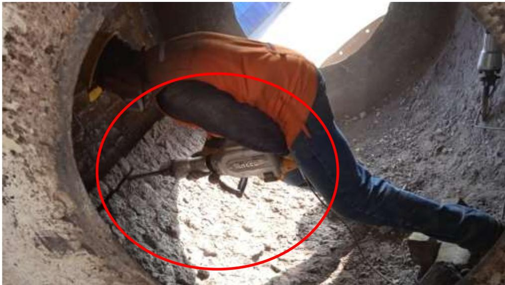
*Figura N°16. Uso y posición inadecuada de taladro.*
