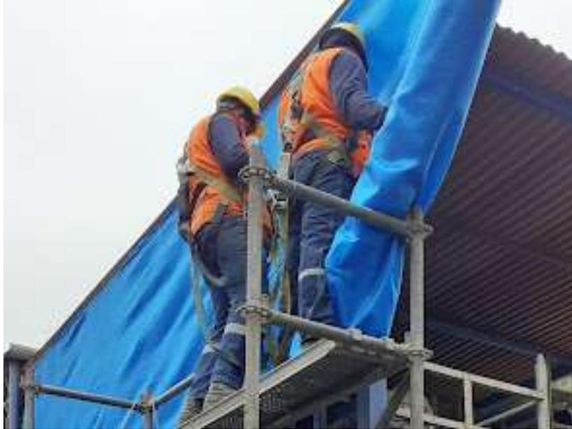
*Figura N°17. Trabajo en altura -dotación necesaria de EPP'S.*
