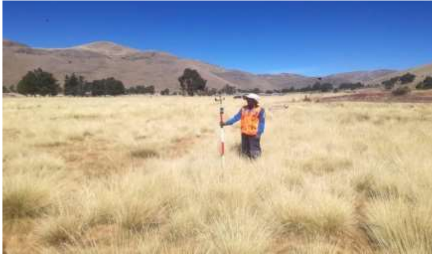
Figura 10. Levantamiento topográfico línea conducción
