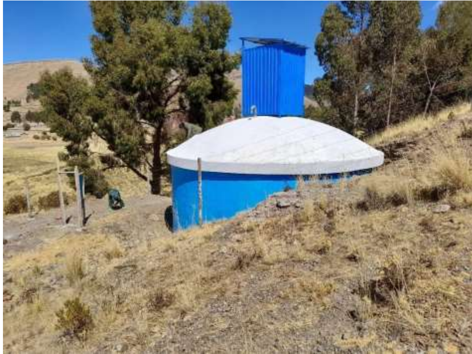
Figura 8. Estructura Del Reservorio
