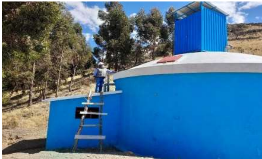
Figura 11. Verificación del reservorio
