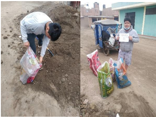
Extracción de la Calicata-2
