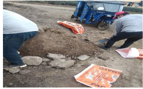
Extracción de la Calicata-1
