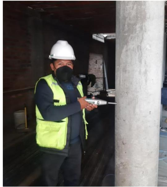
Se realiza el ensayo de esclerometría en columna circular de la vivienda 02.
