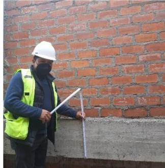
**Figura 16.** *Toma de medida de viga principal*
