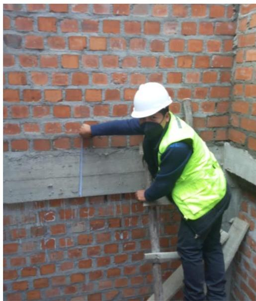
Se aprecia la medición de una viga principal para rellenar la ficha de recolección de datos de la vivienda 01.
