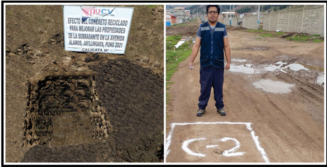
Figura 14. Ubicación de calicatas N° 2 en progresiva 0+250
