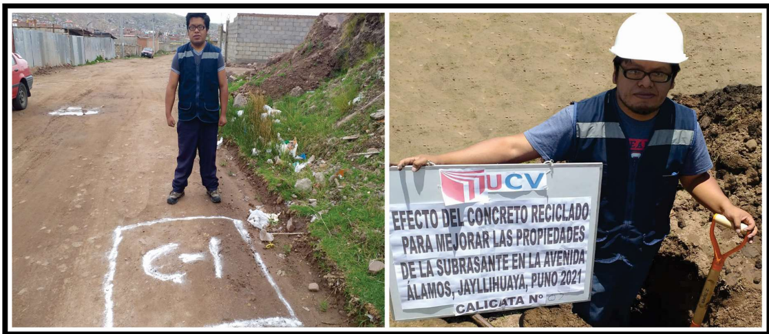
Figura 13. Ubicación de calicatas N° 1 en progresiva 0+000
