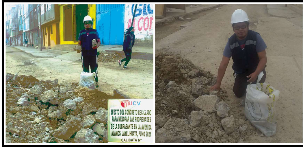
Figura 18. Obtención del concreto reciclado
