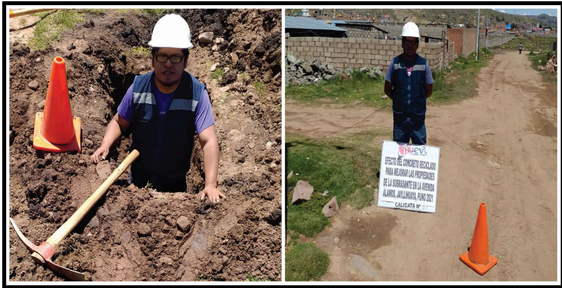
Figura 16. Ubicación de calicatas N° 4 en progresiva 0+750
