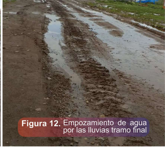
Figura 10. Empozamiento de agua por las lluvias
