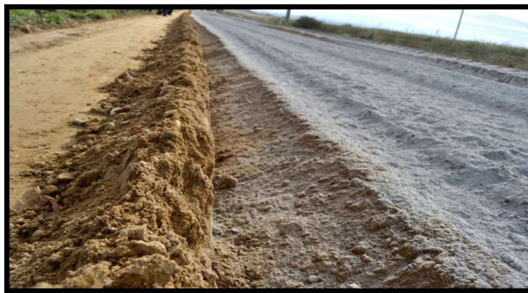
Figura 8. Estabilización de suelos
