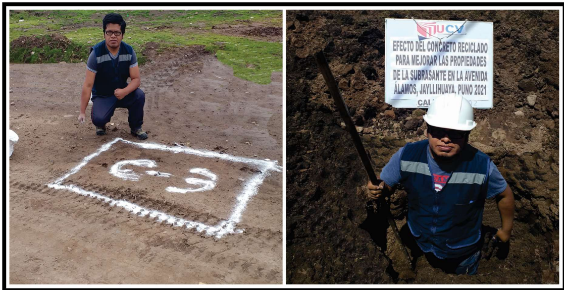
Figura 15. Ubicación de calicatas N° 3 en progresiva 0+500
