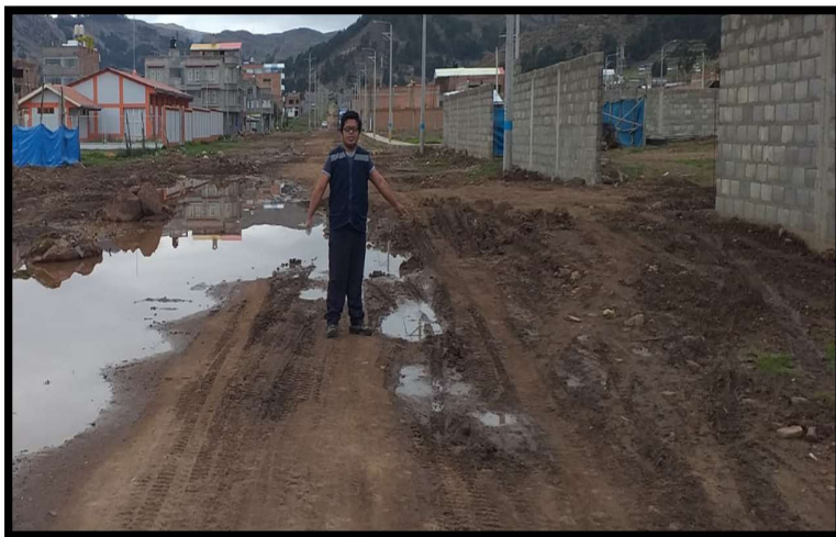
Figura 3. Deterioro de la avenida Álamos- Jayllihuaya
