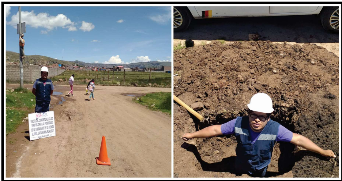
Figura 17. Ubicación de calicatas N° 5 en progresiva 1+000
