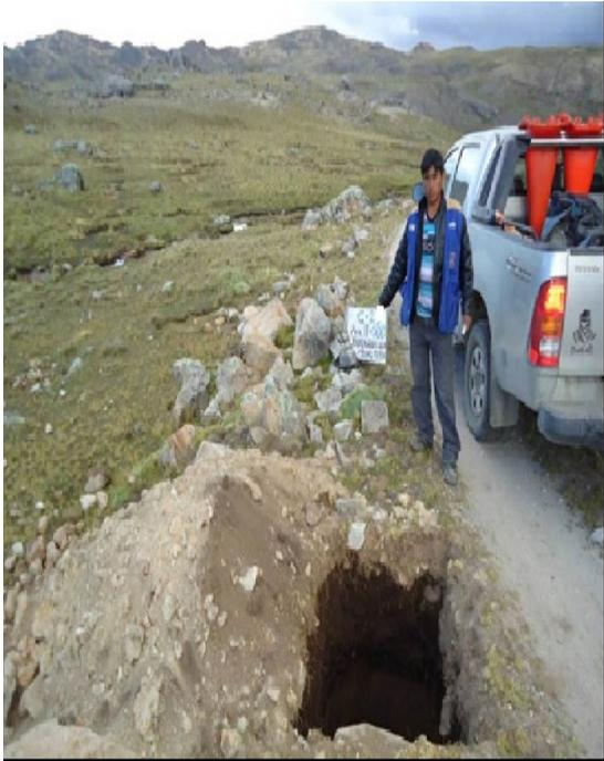
**Fotografía 01:** excavación de calicatas
