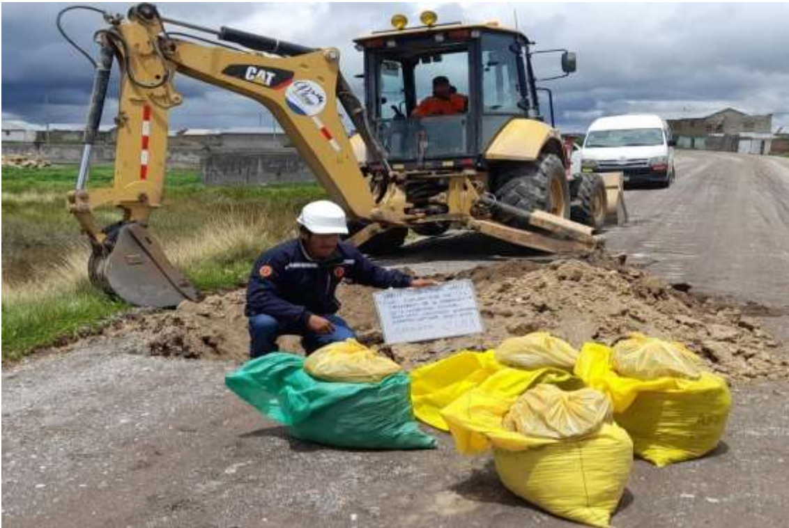
Realización de exploración de la calicata C – 03
