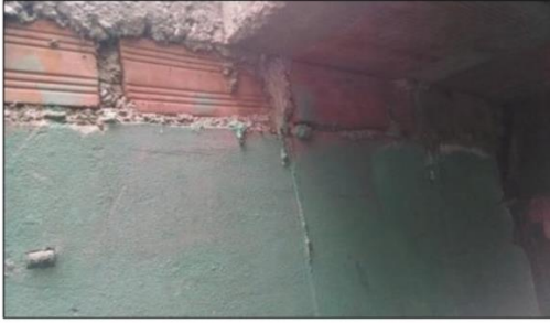
Unión muro y techo.
