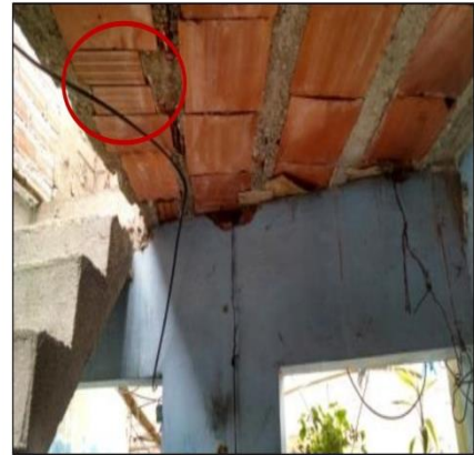
Uso de ladrillos pandereta de muros para techo.
