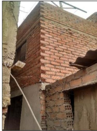
Muro portante con ladrillos pandereta.
