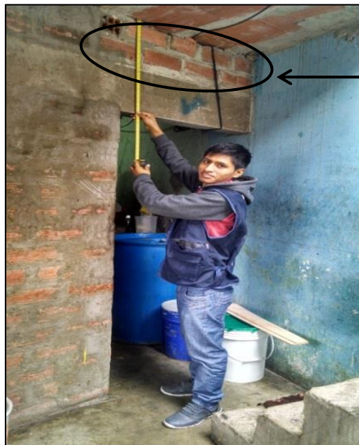
Figura 26: Hileras de ladrillo sobre la viga solera.
