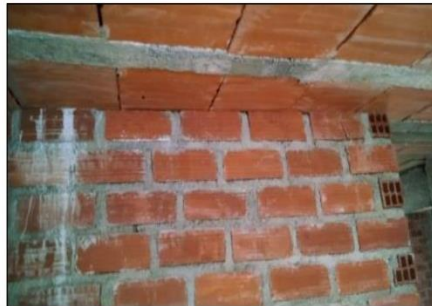
Unión muro y techo.
