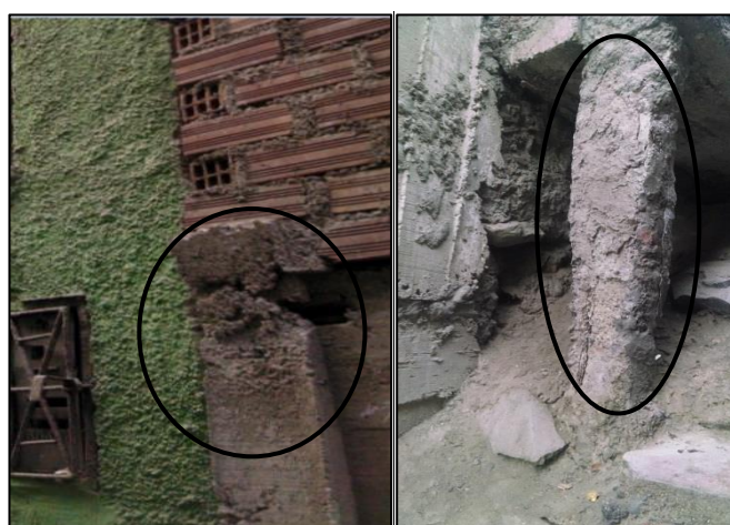
Figura 31: Viviendas con cangrejera en columna.
