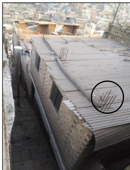
Figura 33: Exposición de acero a la intemperie.
