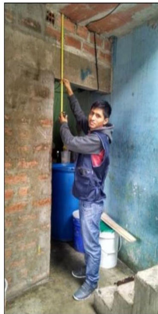
Muro portante con ladrillos pandereta
