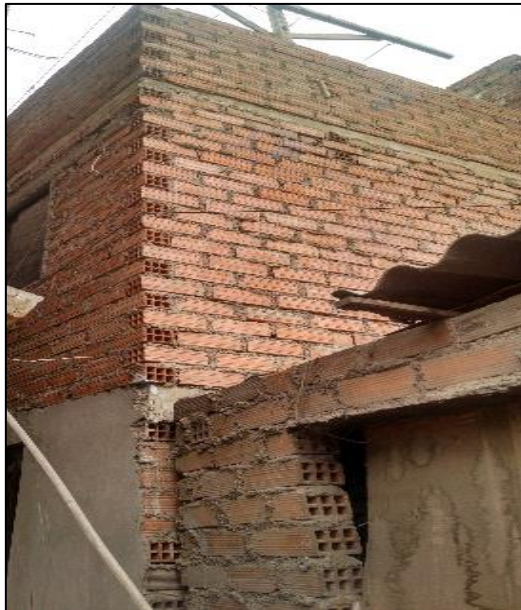
Figura 27: Viviendas con muros portantes de ladrillo pandereta.
