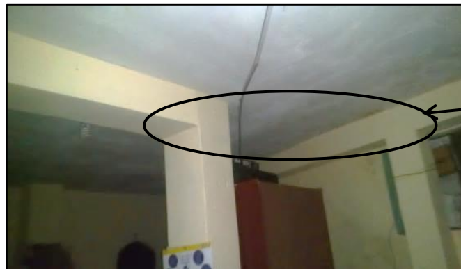
Figura 29: Discontinuidad de elementos resistente.
