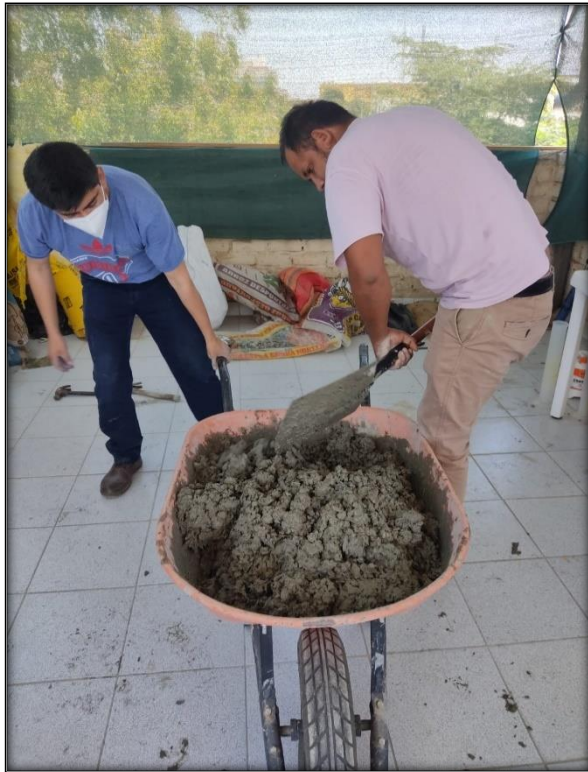
Imagen 10 y 11: Preparación de mezcla de concreto con adición de lana de
