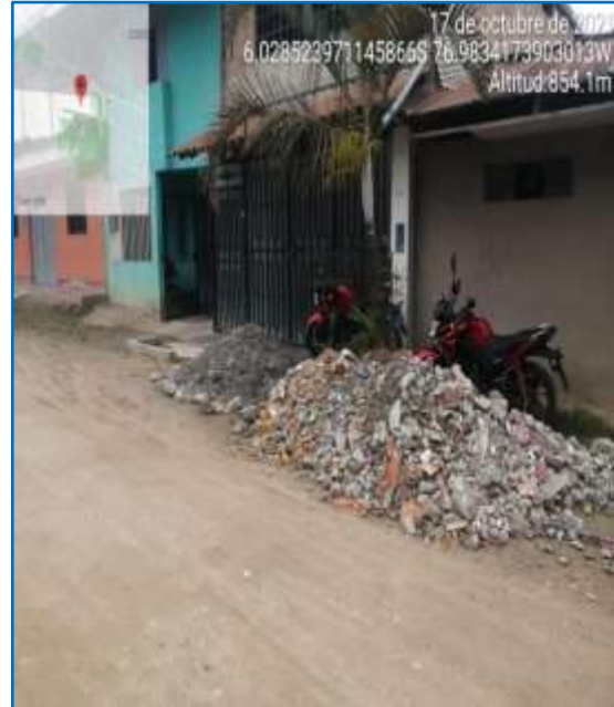
Fotografía N°3: Extracción de material de demolición de elementos estructurales de concreto RCD
