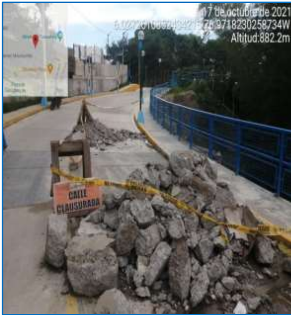
Fotografía N°3: Extracción de material de demolición de elementos estructurales de concreto RCD
