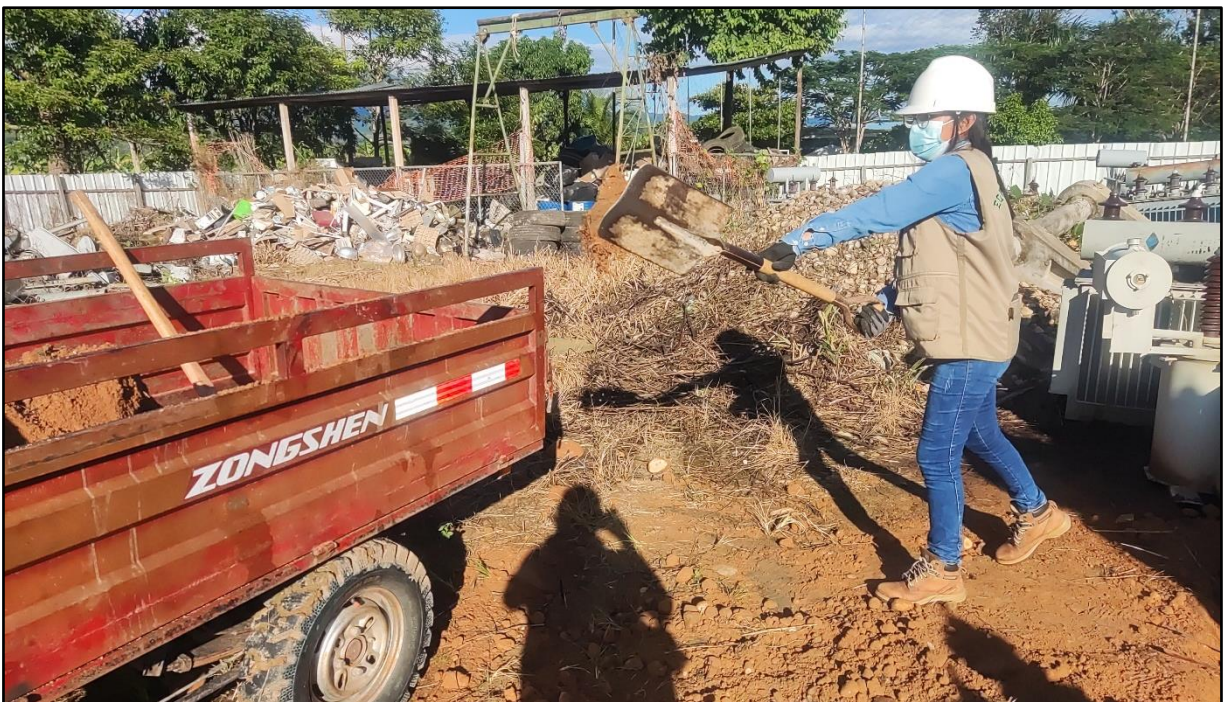
Carga de del suelo impactado por BPC para ser transportado y tratado ex-situ. Fuente: Elaboración propia, 2021.
