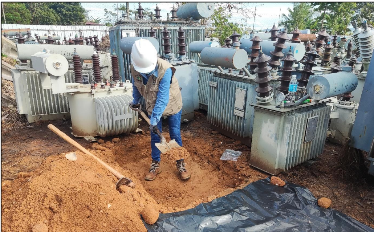
Calicata para la obtención de la muestra de suelo – Identificación del contaminante. Fuente: Elaboración propia, 2021.
