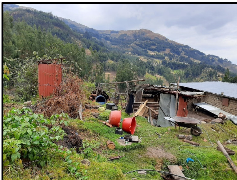
Figura 39. Problemática de la comunidad Manta
