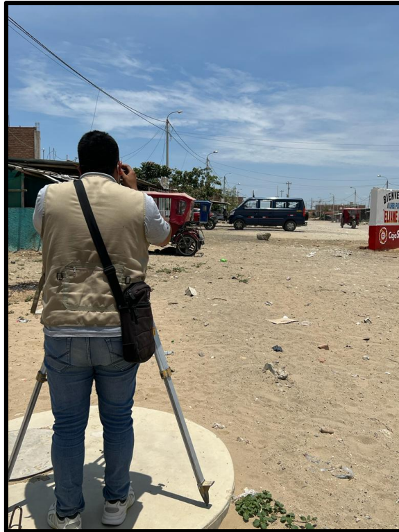
Figura 22: Levantamiento topográfico, buzón existente en la vía Fuente: Elaboración propia
