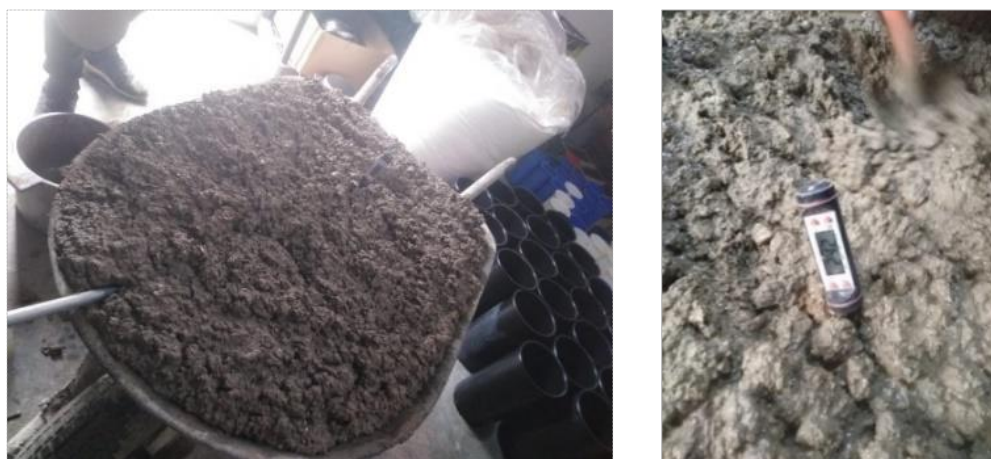
Figura N° 8. Medición de la temperatura del concreto mediante el uso del termómetro.
