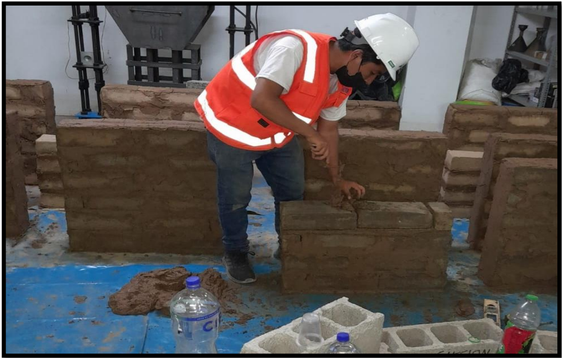
Figura 23: Elaboracion de Muretes y pilas de adobe para ensayo
