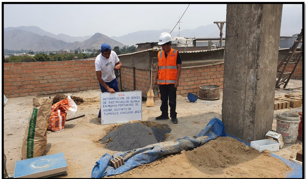
Figura 01: Mezcla de suelo con ceniza.
