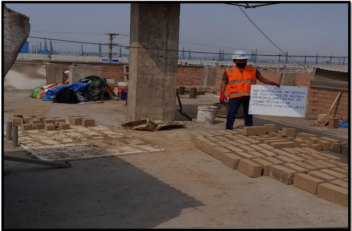
Figura 16: Elaboracion y secado de adobes con patron
