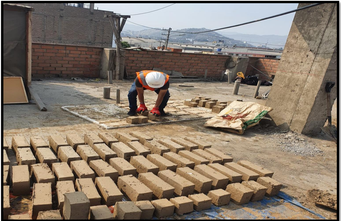
Figura 21: Elaboracion de adobes con 2% de ceniza de rastrojos de quinua
