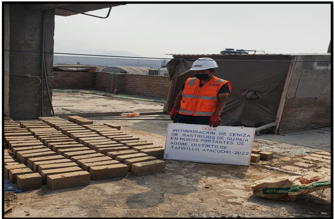
Figura 19: Elaboracion de adobes con 2% de ceniza de rastrojos de quinua.
