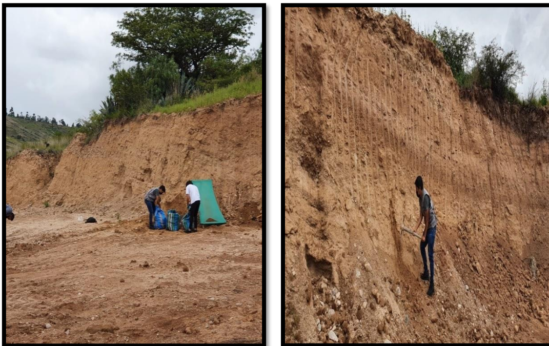
Figura 22. Ubicación de la cantera de extracción de tierra para adobe, Tambillo – Ayacucho.
