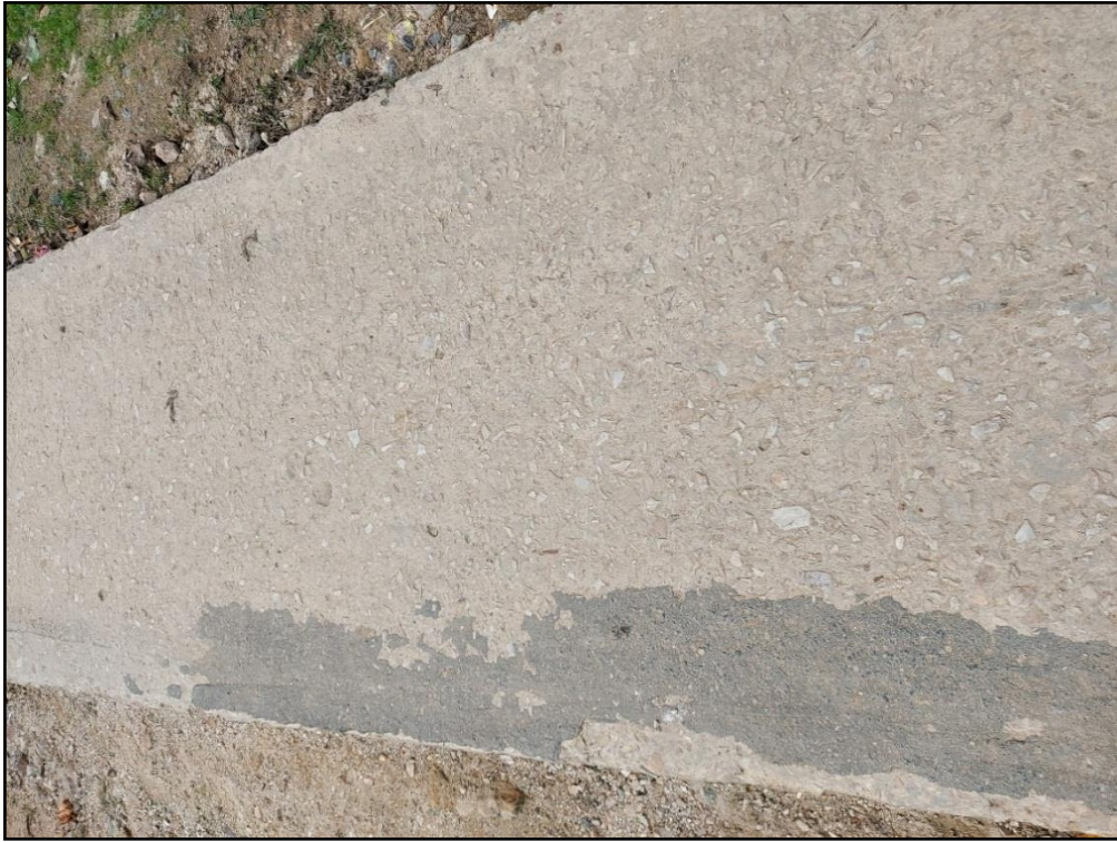
FOTOGRAFÍA 47: INICIO DE JR. BOLÍVAR - CUADRA 01
