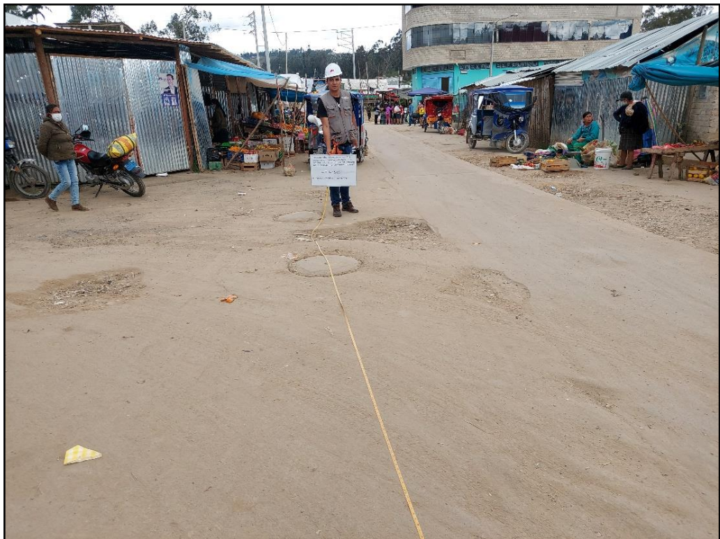
FOTOGRAFÍA 16: PULIMENTO DE AGREGADOS (FIN DE TRAMO)
