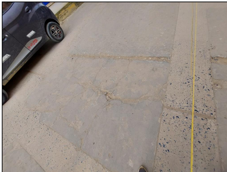
FOTOGRAFÍA 02: MEDICION DE LONGITUD DE JR. 22 DE OCTUBRE
