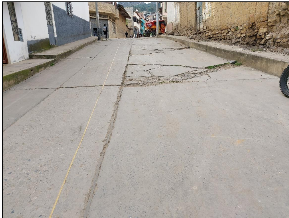
FOTOGRAFÍA 46: PULIMENTO DE AGREGADOS, GRIETA LINEAL SELLO DE JUNTA, LOSA DIVIDIDA, DESCONCHAMIENTO, GRIETA EN ESQUINA
