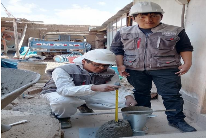
Determinación del SLUMP de concreto.
