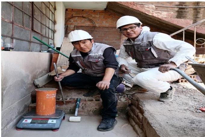
Toma del peso unitario del concreto fresco.
