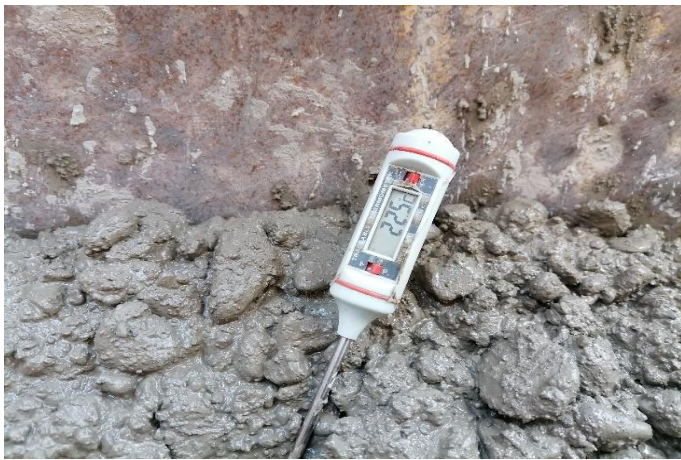
Temperatura del concreto fresco.
