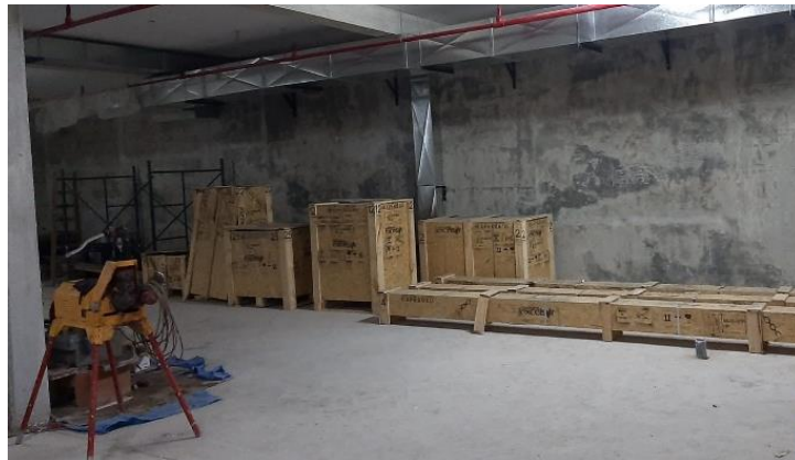
Figura 21. Cajas con las partes del ascensor
