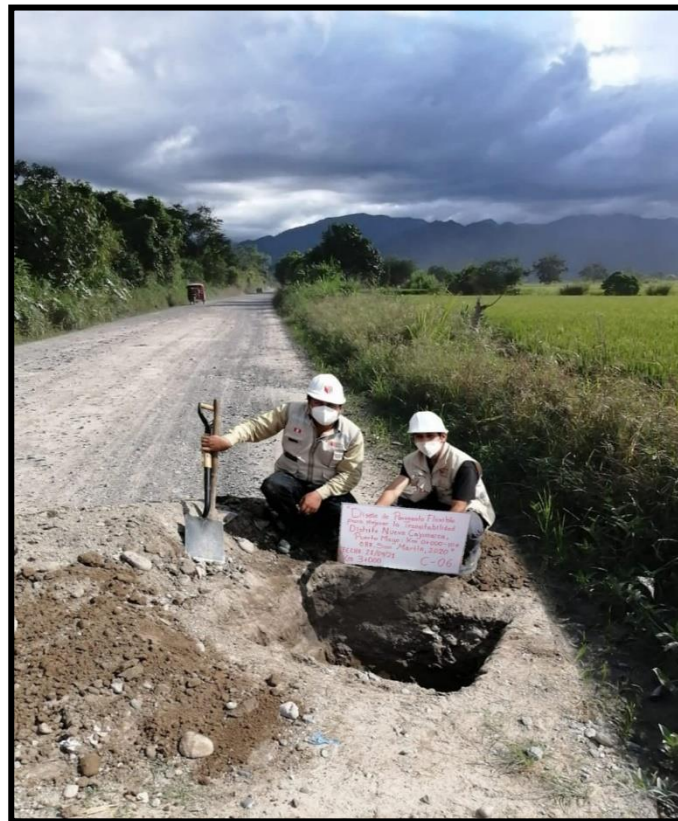
Figura 15: Calicata n°3 – km 2+500.
