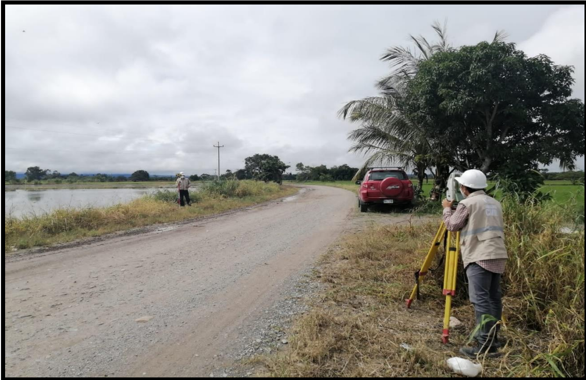
Figura 12: Levantamiento topográfico en el transcurso de la carretera de estudio.
