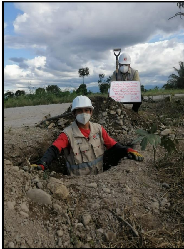
Figura 16: Calicata n°4 – km 4+500.
