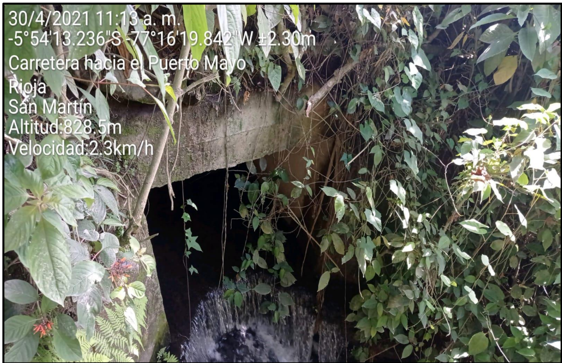
Figura 14: Estado situacional de las obras de arte (Alcantarillas Tipo cajón).
