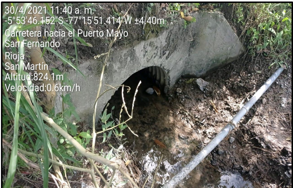
Figura 13: Estado situacional de las obras de arte (Alcantarillas TMC).
