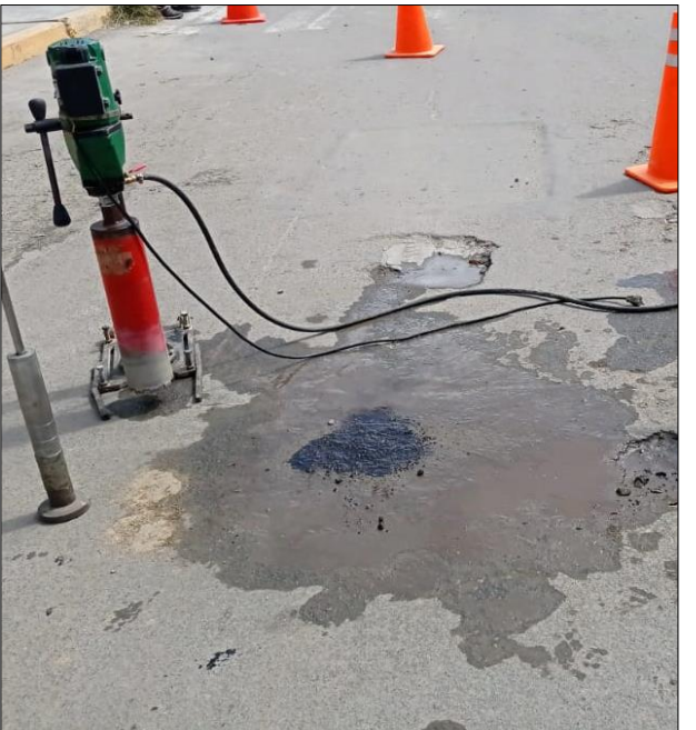
Extracción de diamantinas de la Av. Chiclayo
