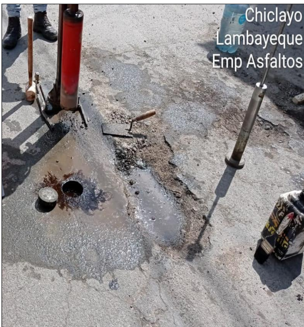
Extracción de diamantinas de la Av. Chiclayo
