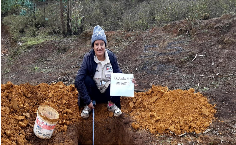
Figura 73. Verificación de la altura de la calicata N° 12
