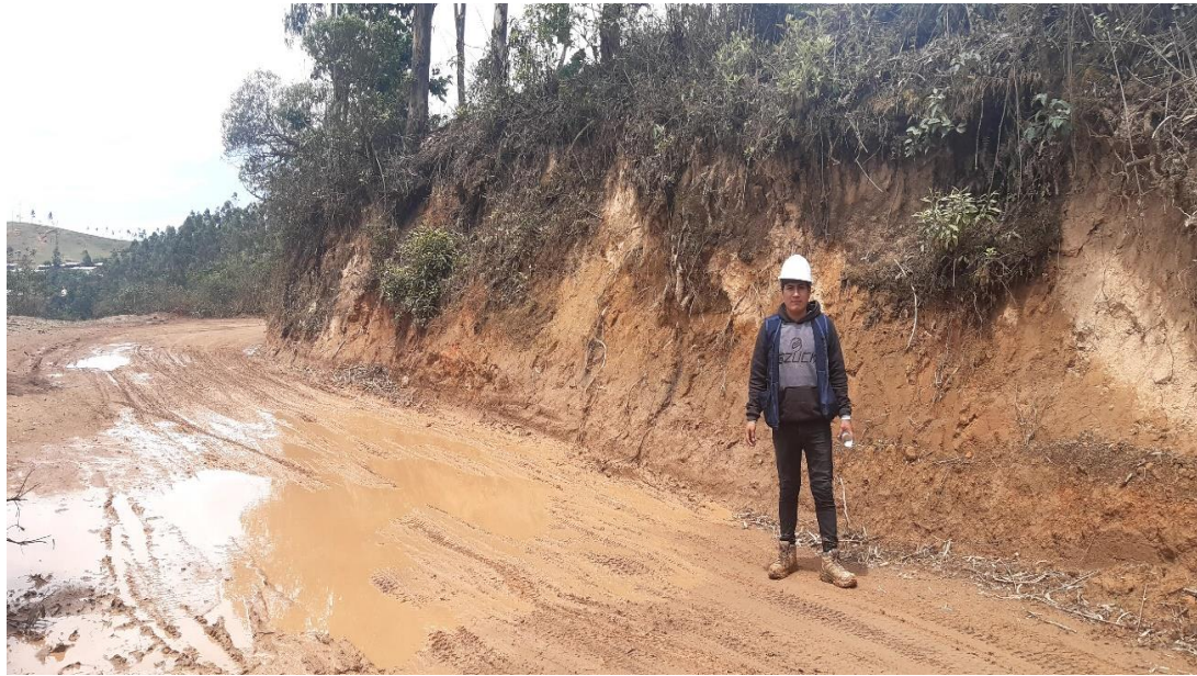
Figura 14. Tramo Huarmaca – Yatama (km 7+450.00).
