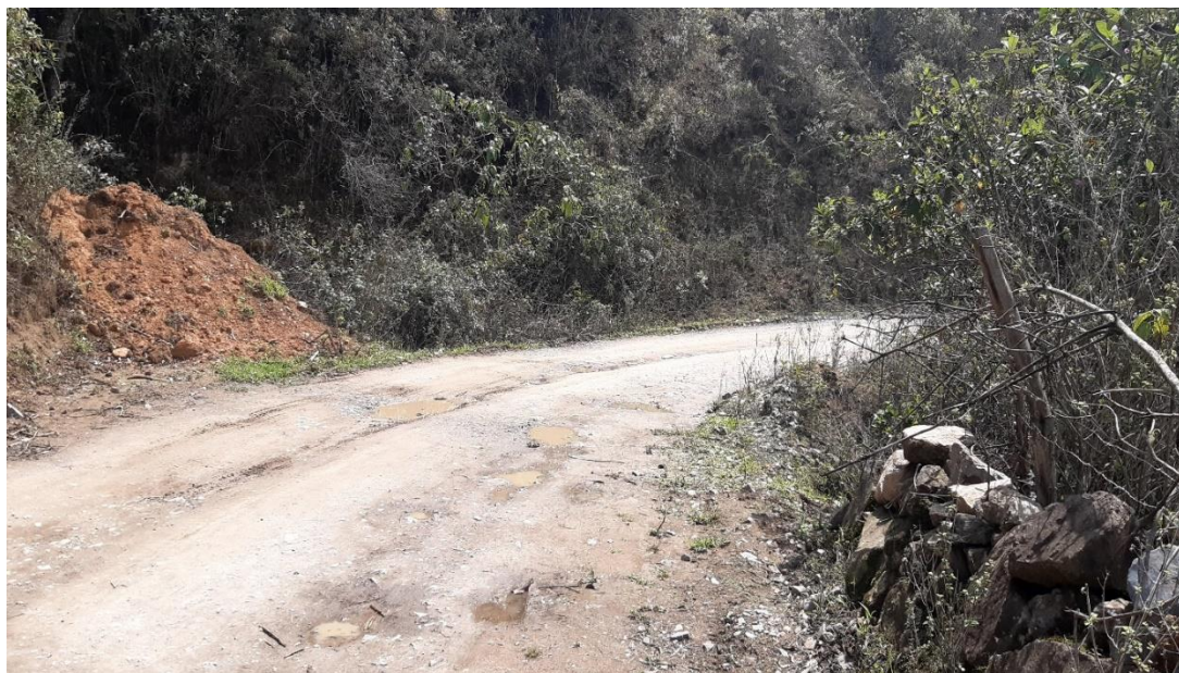
Figura 11. Tramo Huarmaca – Yatama (km 2+498.00).
