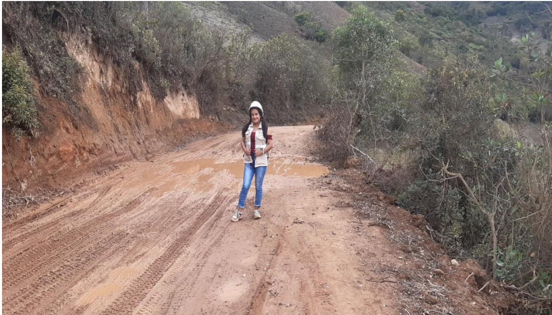
Figura 17. Tramo Huarmaca – Yatama (km 9+700.00).
