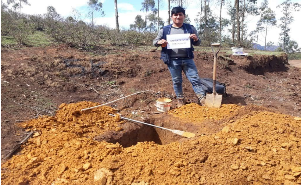
Figura 75. Excavación de calicata N° 11.
