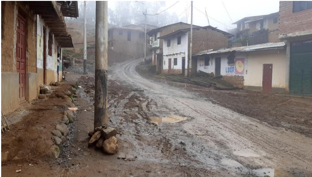
Figura 10. Tramo Huarmaca – Yatama (km 0+100.00).
