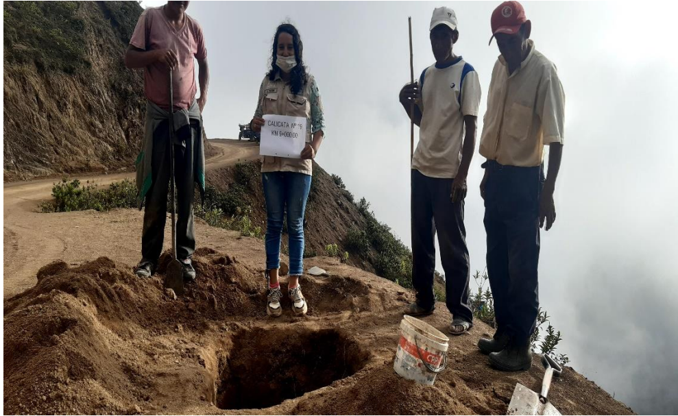
Figura 71. Excavación de calicata N° 19
