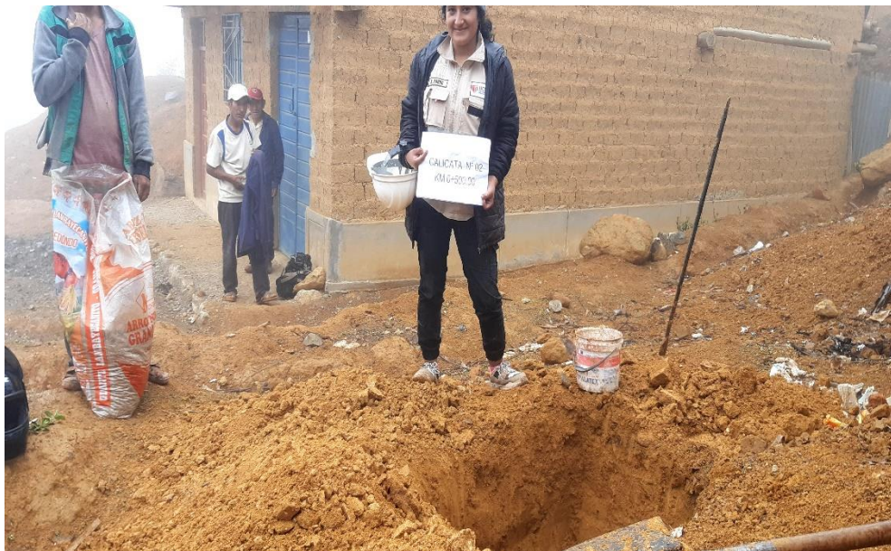
Figura 74. Excavación de calicata N° 2
