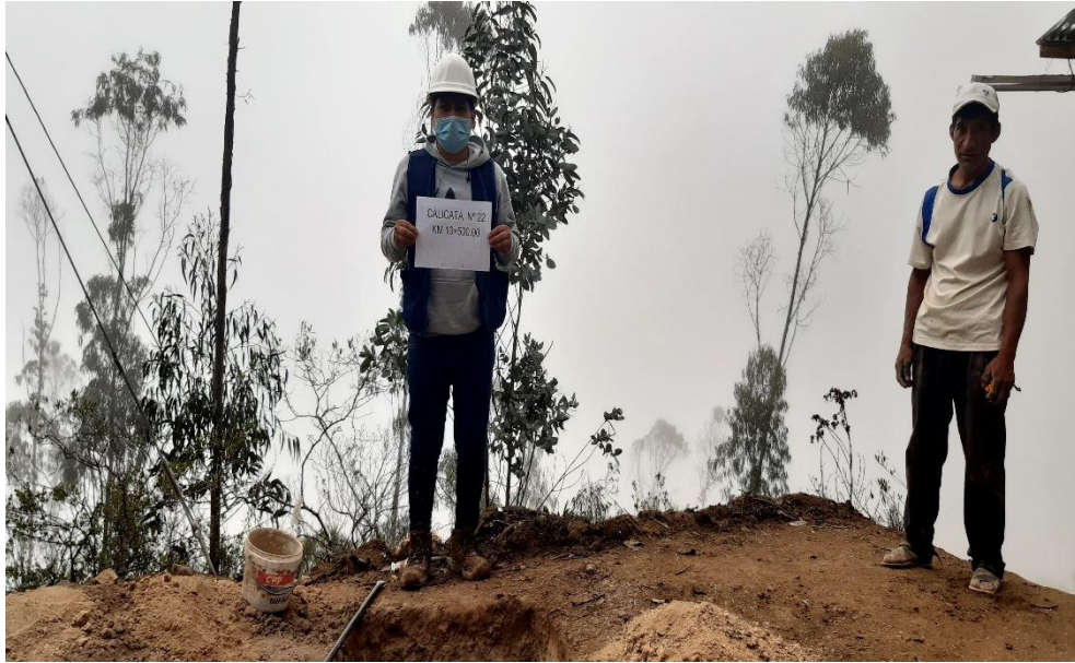
Figura 79. Excavación de calicatas N° 22.
