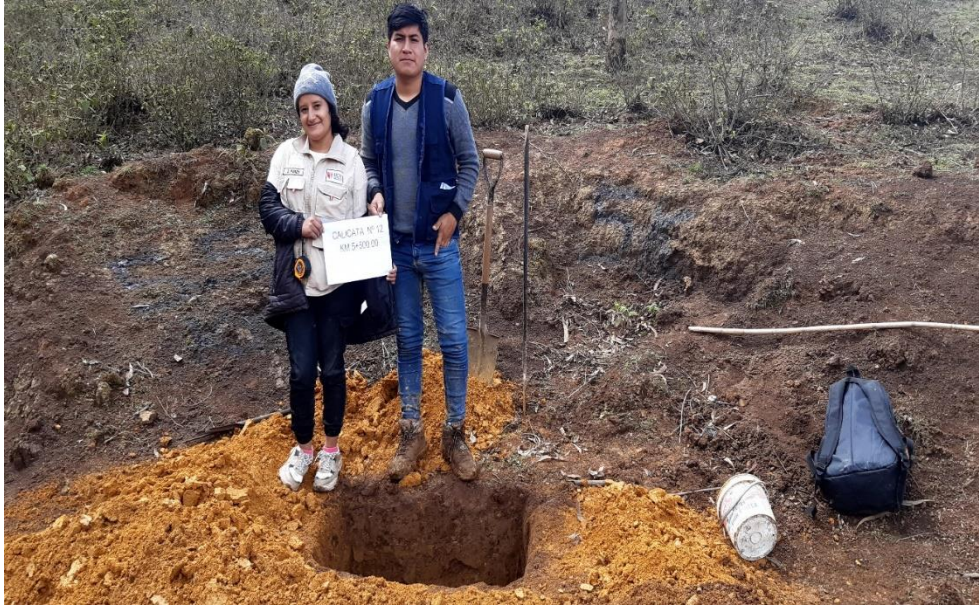
Figura 69. Excavación de calicata N° 12
