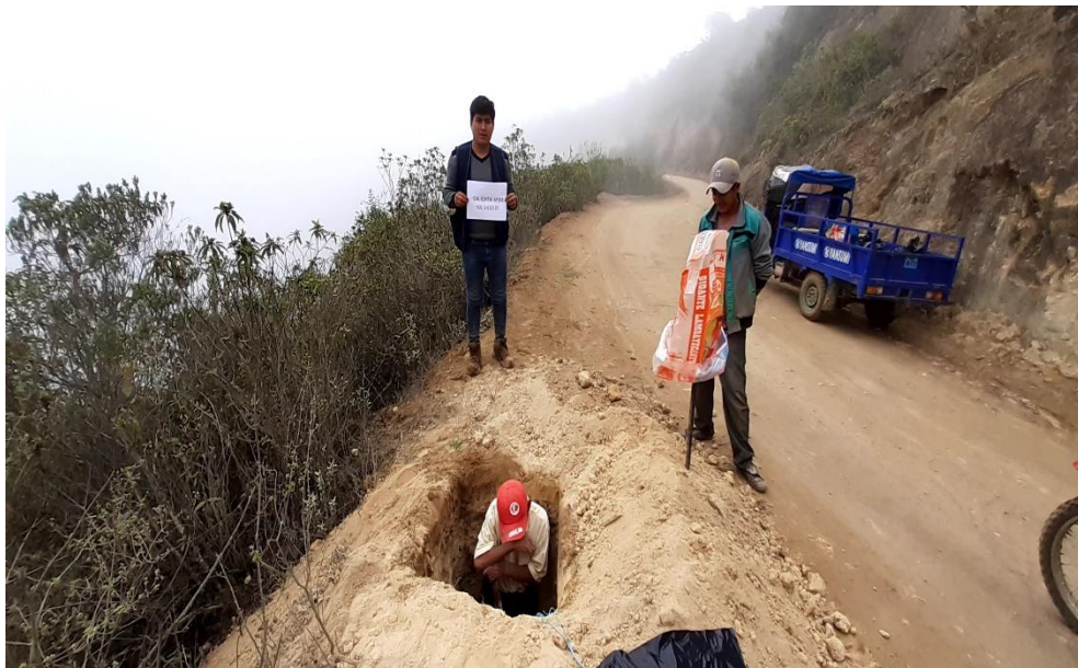
Figura 80. Excavación de calicata N° 8.
