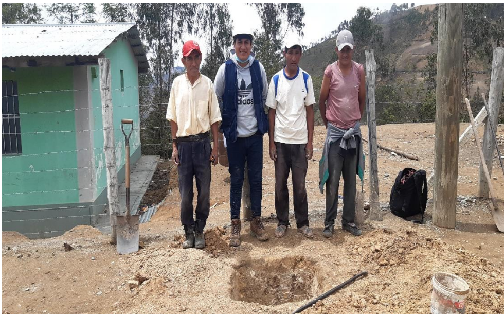
Figura 70. Excavación de calicata N° 23
