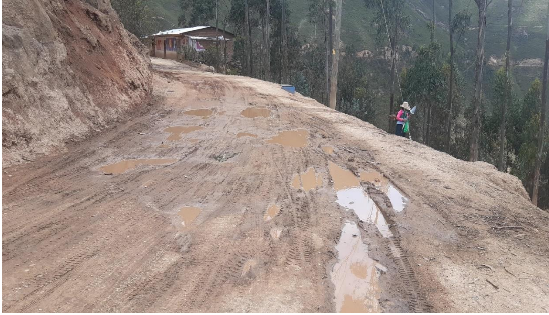
Figura 16. Tramo Huarmaca – Yatama (km 8+150.00).
