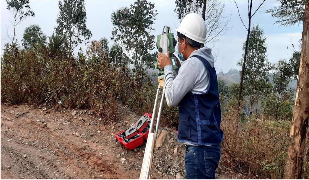
Figura 35. Levantamiento topográfico por tramos.
