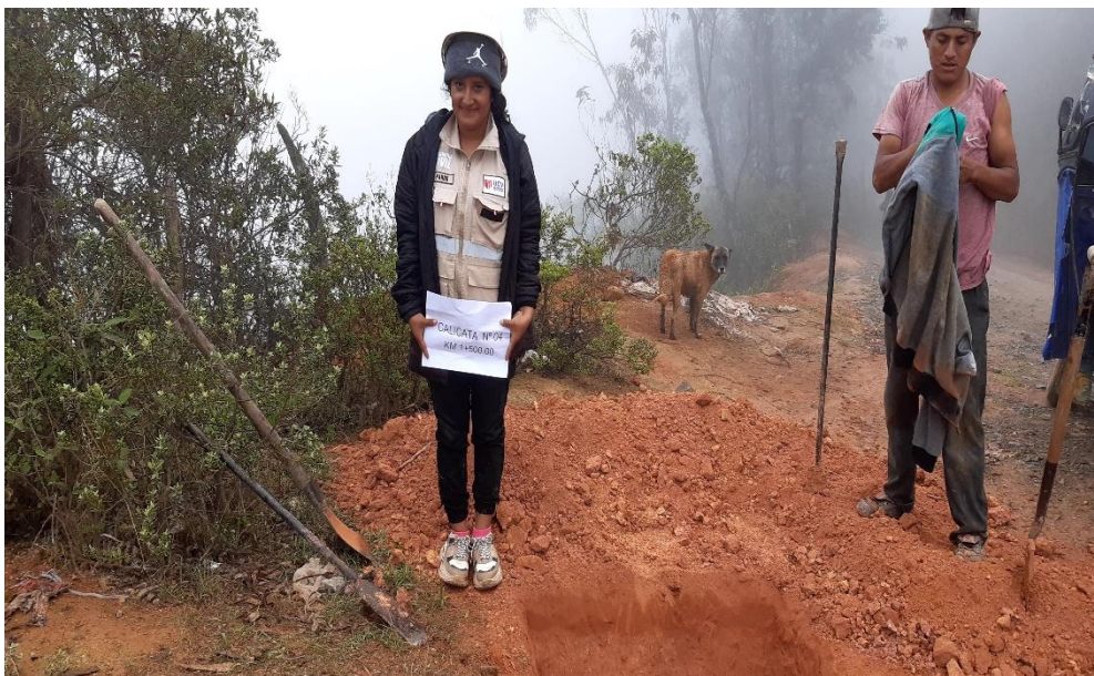
Figura 76. Excavación de calicata N° 4.
