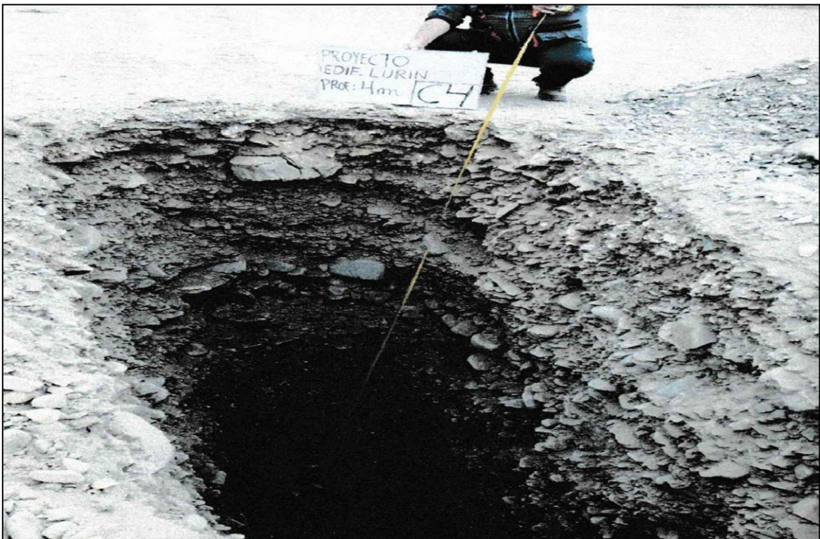
Figura 43. Calicata C4 a profundidad 4,00 m
