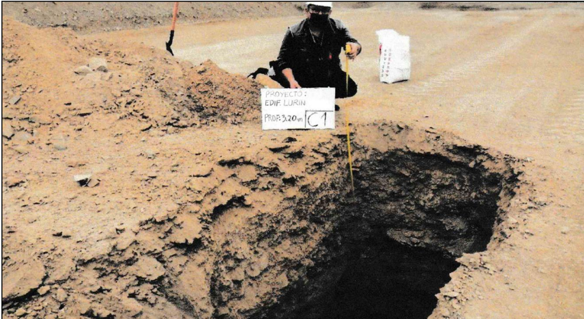
Figura 40. Calicata C1 a profundidad 3,20 m
