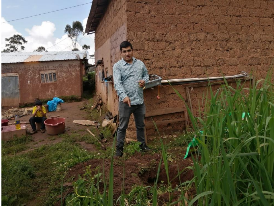
Anexo 61 Excavación de calicata N° 01 dentro de vivienda.
