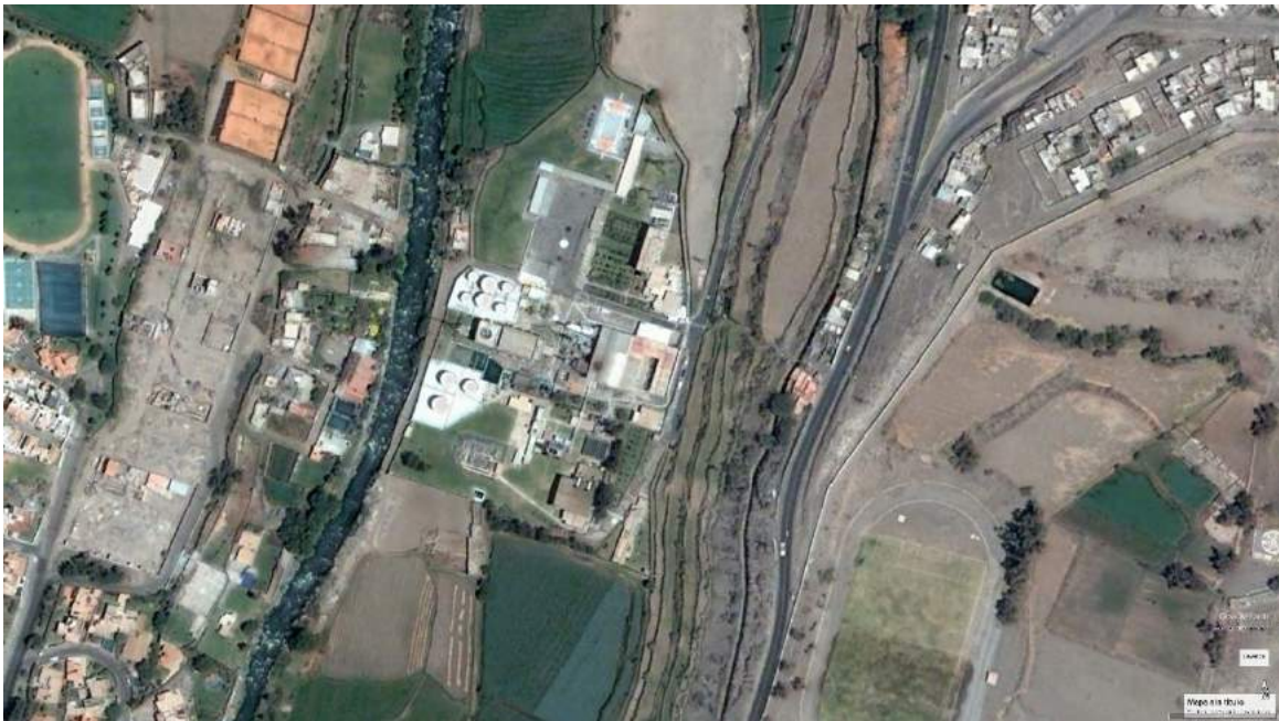
Imagen EGASA en el año 2004, antes de la construcción del Pte. Chilina
