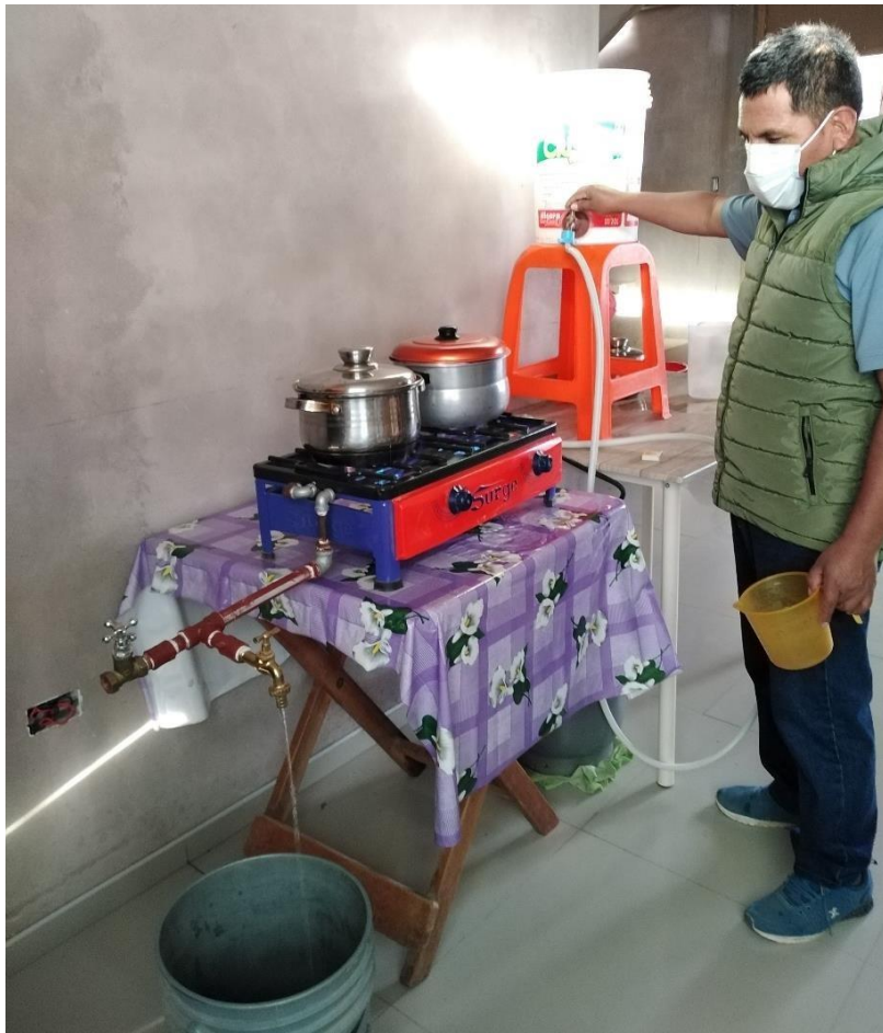
Regulación del flujo del agua que circula por la tubería
