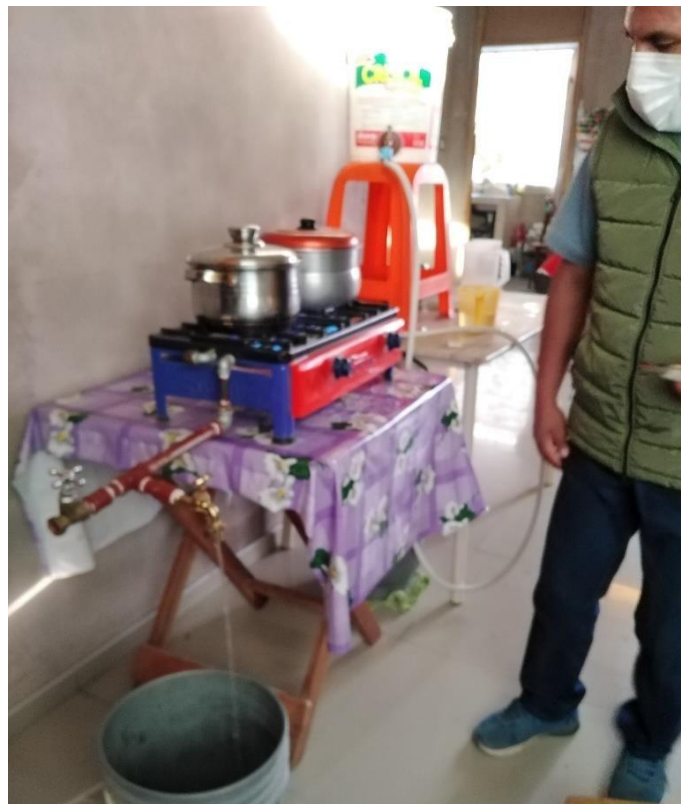
Sistema de calentador de agua durante su funcionamiento
