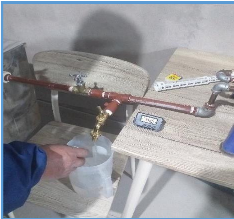
Figura 22: Medición de flujo y temperatura del agua caliente
