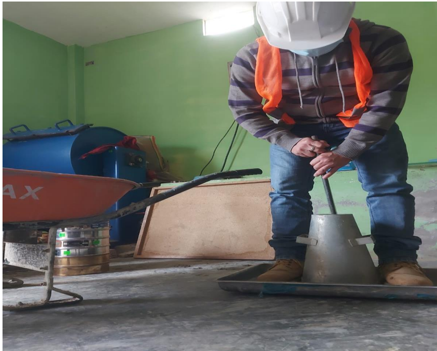
Foto 3. Se aprecia realizando la prueba del slump
